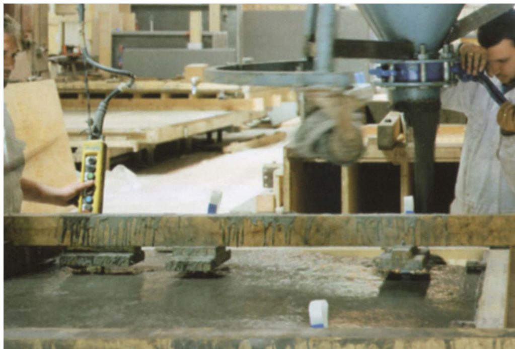
68. Realizzazione pannelli in Ductal ® , Centro Bus RATP, ECDM, Thiais
