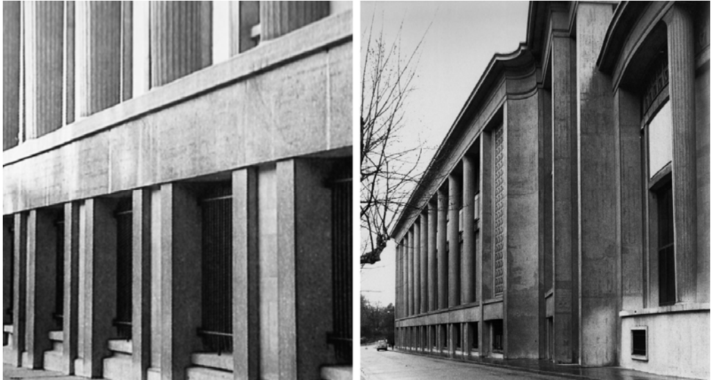
4. Musée des Travaux Publics, Perret, Parigi, 1936-1948
