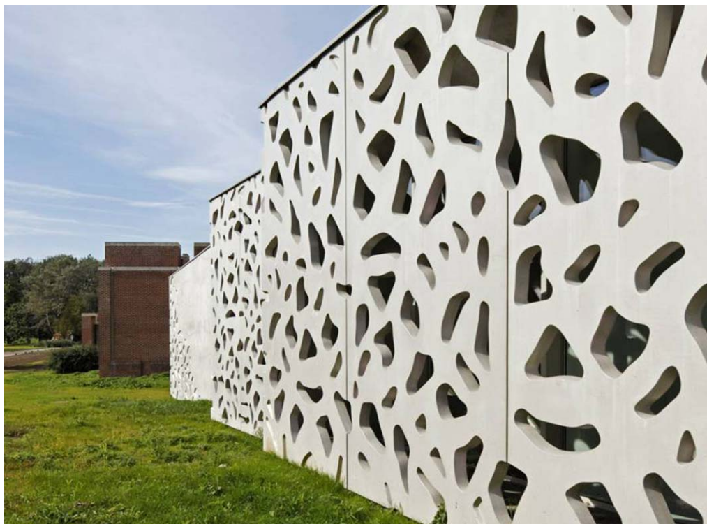
72. Veduta esterna, LAM, Gautrand, Villeneuve d'Ascq
