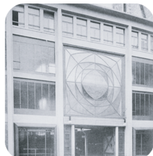
Garage in rue de Ponthieu Perret, Parigi
