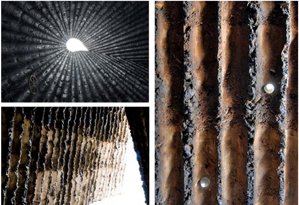
60. Superficie interna, Cappella di Bruder Klaus, Zumthor, Eifel, 2007
