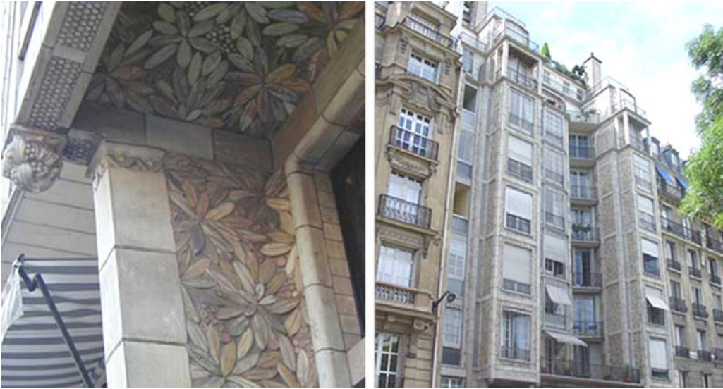
21. Casa in rue de Franklin, Perret, Parigi, 1903
