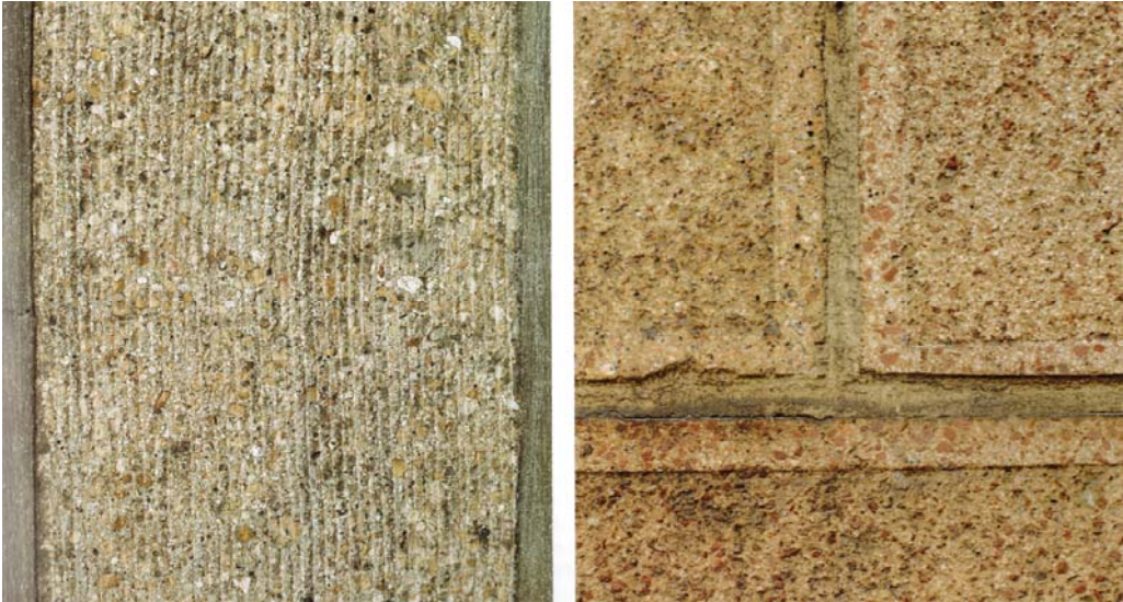
23. Particolari superfici, Musée des Travaux Publics, Perret, Parigi, 1946
