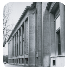
Musée des Travaux Publics Perret, Parigi
