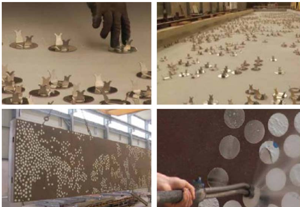
57. Lavorazione pannelli, Centro di archiviazione EDF, LAN, Bure-Saudron, 2011
