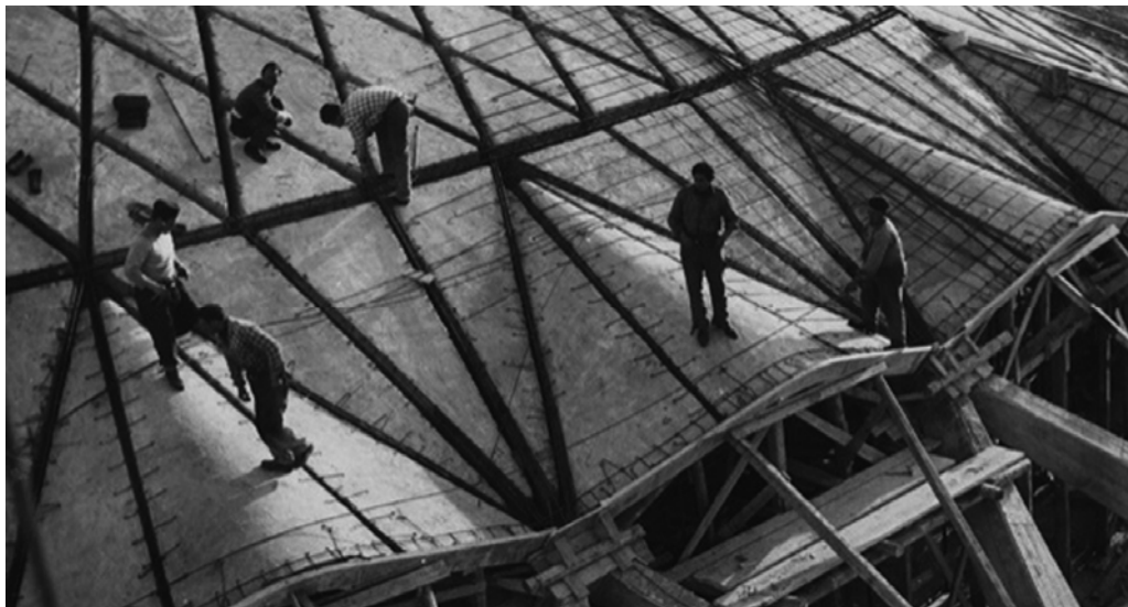
13. Cantiere Palazzetto dello Sport, Nervi, Roma
