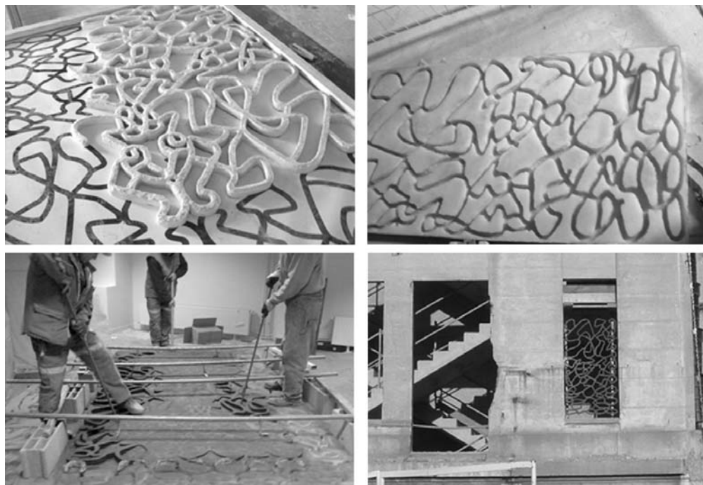
82. Realizzazione griglie in calcestruzzo, Grands Moulins, Ricciotti, Parigi
