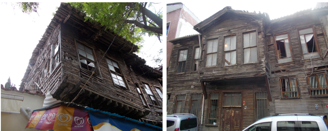
Figg. 3 - 4 Antalya ed Istanbul, esempi di Bağdadi, sistema costruttivo costituito da telai lignei ricoperti da tavole nella faccia esterna ed interna della parete.
