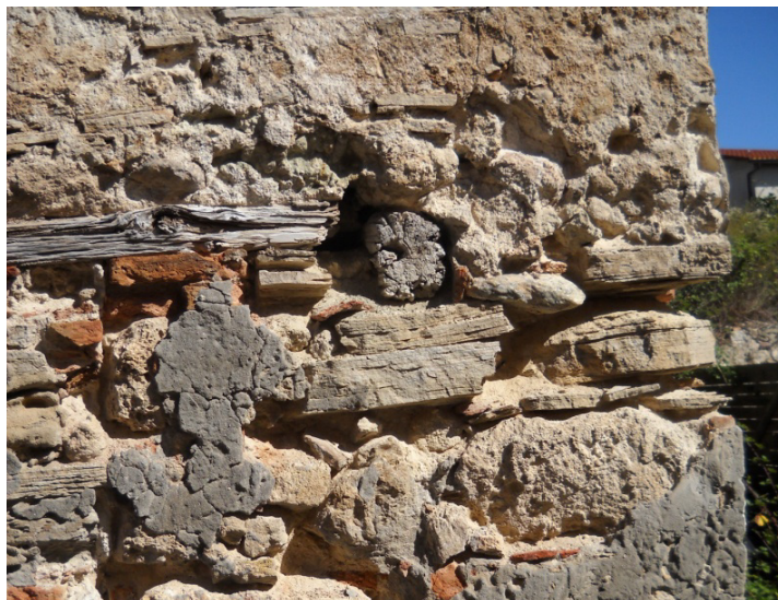
Fig. 89 Particolare del cantonale del fabbricato.
