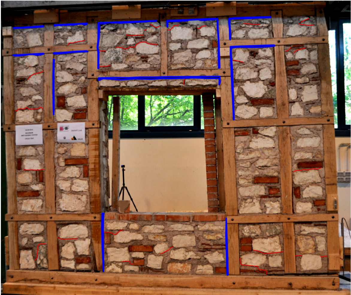
Fig. 64 Rotture e deformazioni in prossimità dello spostamento ultimo. In evidenza l'uplift dei due "maschi" laterali. (in rosso lesioni; in blu distacchi tra telaio ligneo e riempimento in muratura)
