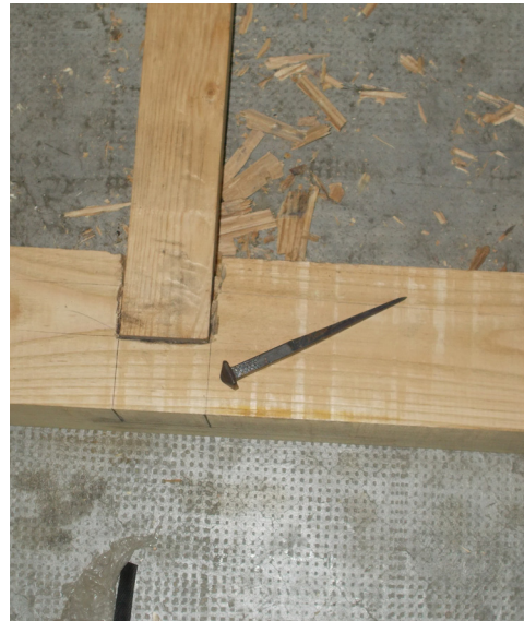
Fig. 59 Campione di parete Borbonica durante la realizzazione
