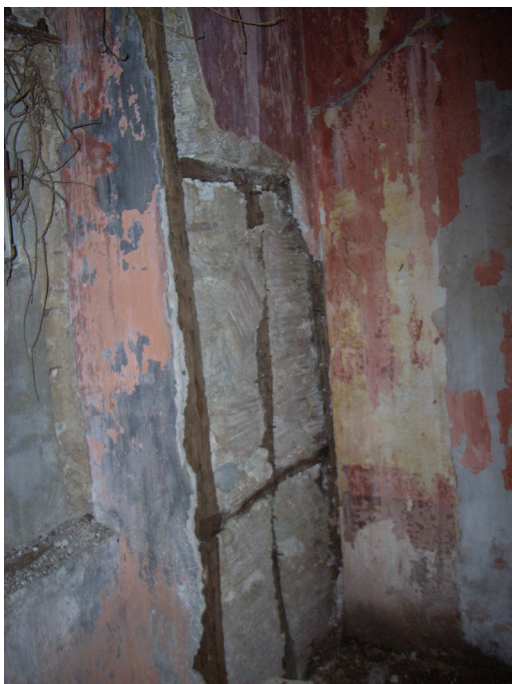
Fig. 85 Il Palazzo vescovile di Mileto, particolare dell'intelaiatura lignea.
