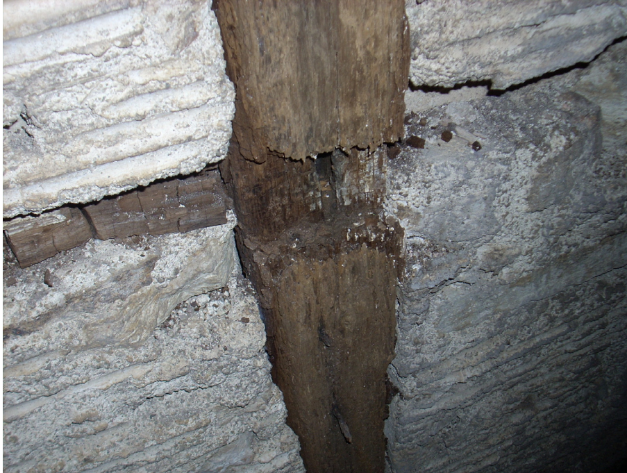
Fig. 87 Avanzato stato di degrado del nodo di un telaio dovuto ad attacco biotico.
