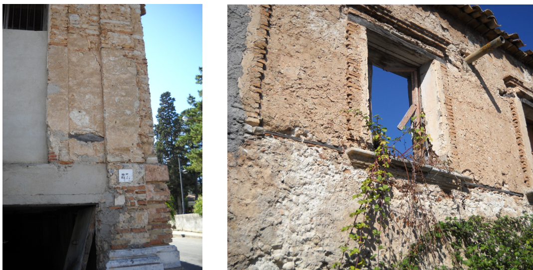
Fig. 86 Il Palazzo vescovile di Mileto, elementi lignei posta sulla parte sterna dell'apparecchio murario.
