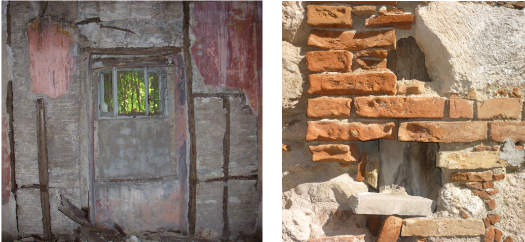
Fig. 91 Differenti tipologie di sistema Borbonico. Il telaio è posto nella parte interna della muratura (fig. a sinistra) o all'esterna (fig. a destra).
