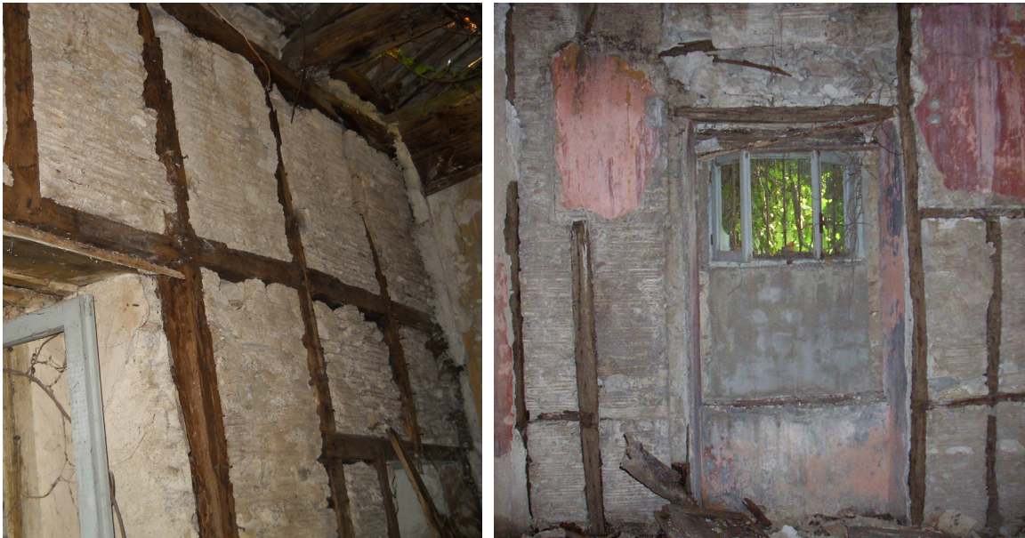
Fig. 18 – 19 Mileto (Vv), Palazzo Vescovile. Particolare dell'intelaiatura lignea.
