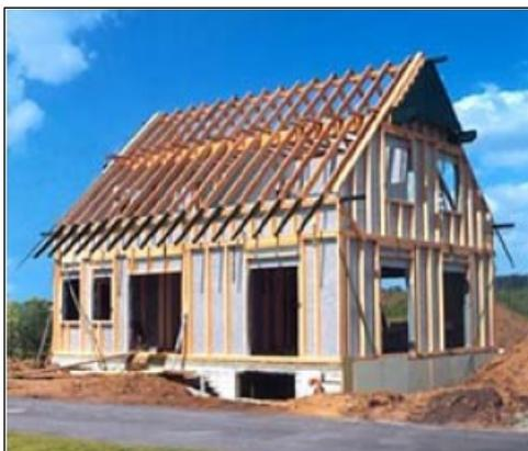
Fig. 3.8. Esempio di edificio con struttura intelaiata tamponata.
