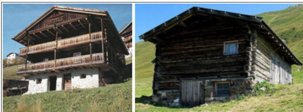
Fig. 3.18. Esempi di organismi edilizi con struttura a tronchi massicci.
