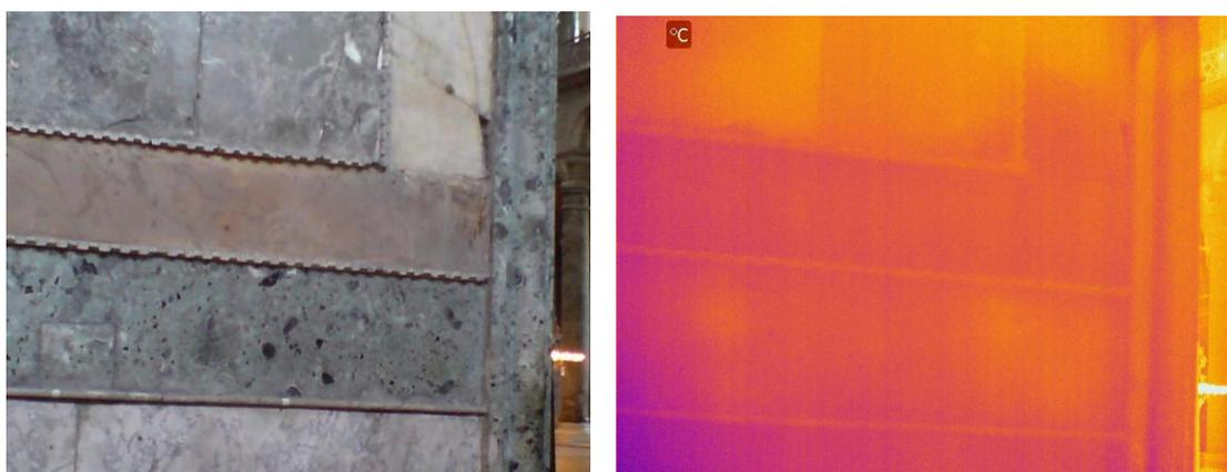
**Fig. 5.31.** Particolare del rivestimento analizzato, immagine dell'area (a sinistra) e termogramma (a destra).
