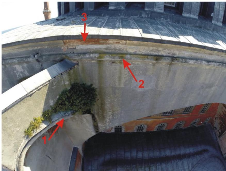
**Fig. 5.10.** Lato nord-est di Santa Sofia in cui è visibile la presenza di piante vascolari (1), patina biologica (2) e distacchi dell'intonaco (3).
