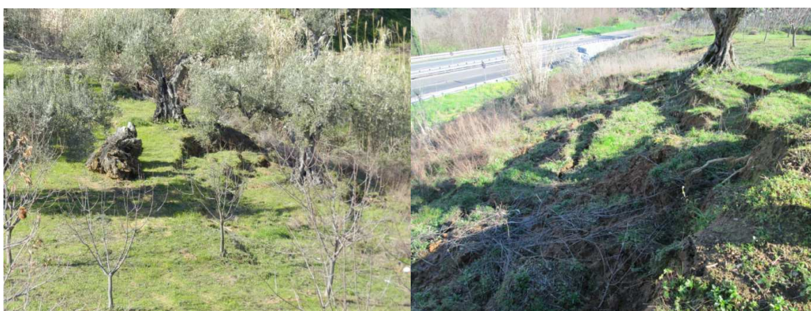
Figura 4.31 Estese fratture longitudinali e trasversali all'interno di una frana attiva localizzata a monte del tracciato autostradale.
