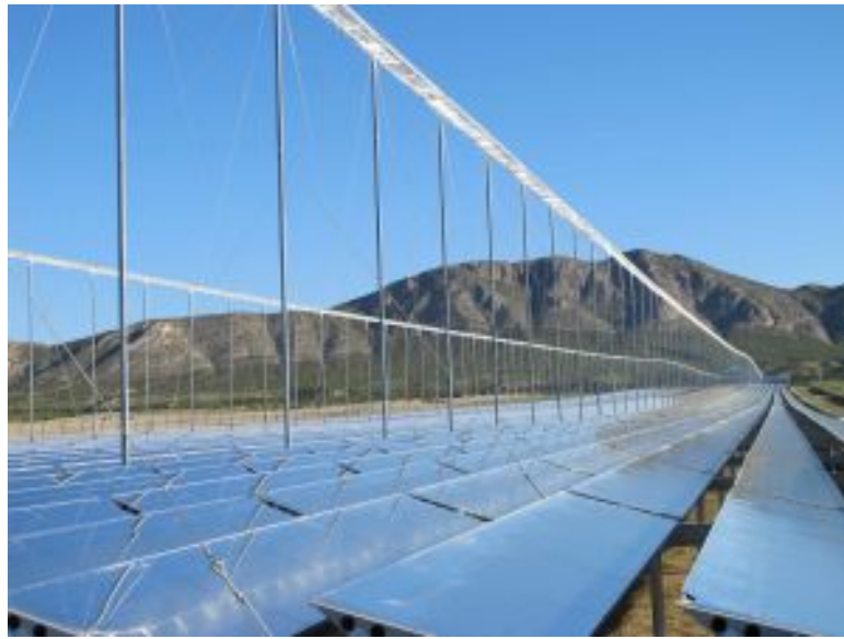
Figura 2.4: Sistema di sostegno dell'assorbitore dal basso [49]
