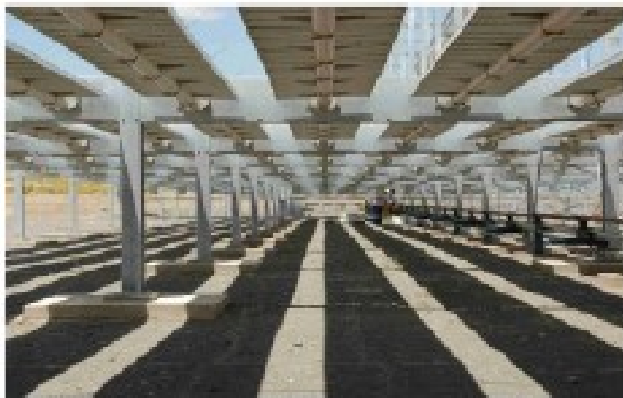
Figura 2.2: Struttura a traliccio [26]
