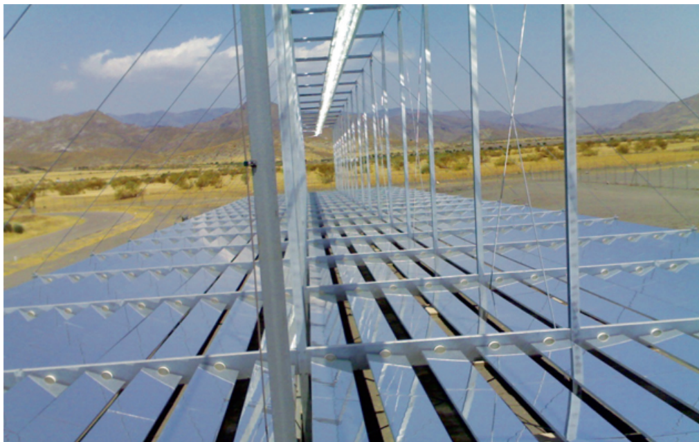
Figura 2.3: Sistema di sostegno dell'assorbitore a lucchetto [48]
