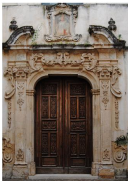
Fig.4. Building 1: "Vergini Convent", Cosenza
