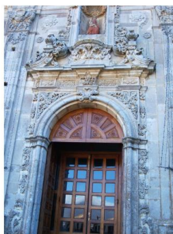
Fig.4. Building 1: "Santa Maria della Serra", Montalto Uffugo (CS)
