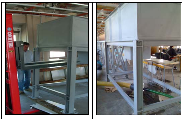
Figura 42: Particolare vasca di accumulo di valle
