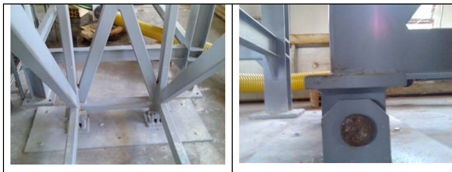
Figura 41: Particolari della cerniera
