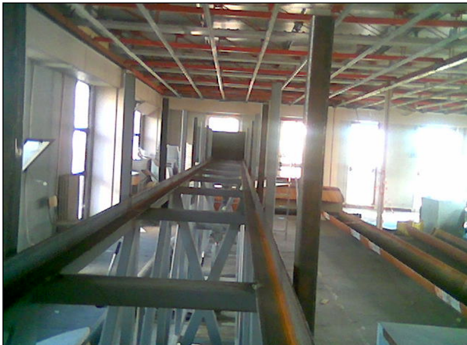
Figura 54: Angolari e piedritti di appoggio alla sezione rettangolare
