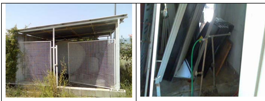
Figura 51: Autoclave esterno e impianto idraulico interno al capannone
