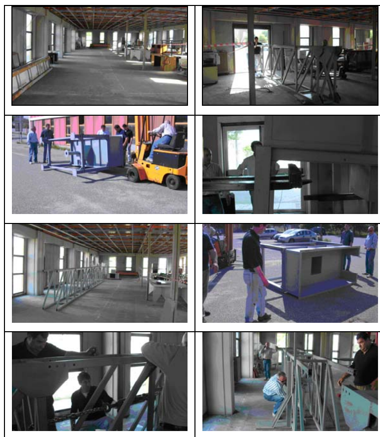
Figura 40: Operazioni di montaggio
