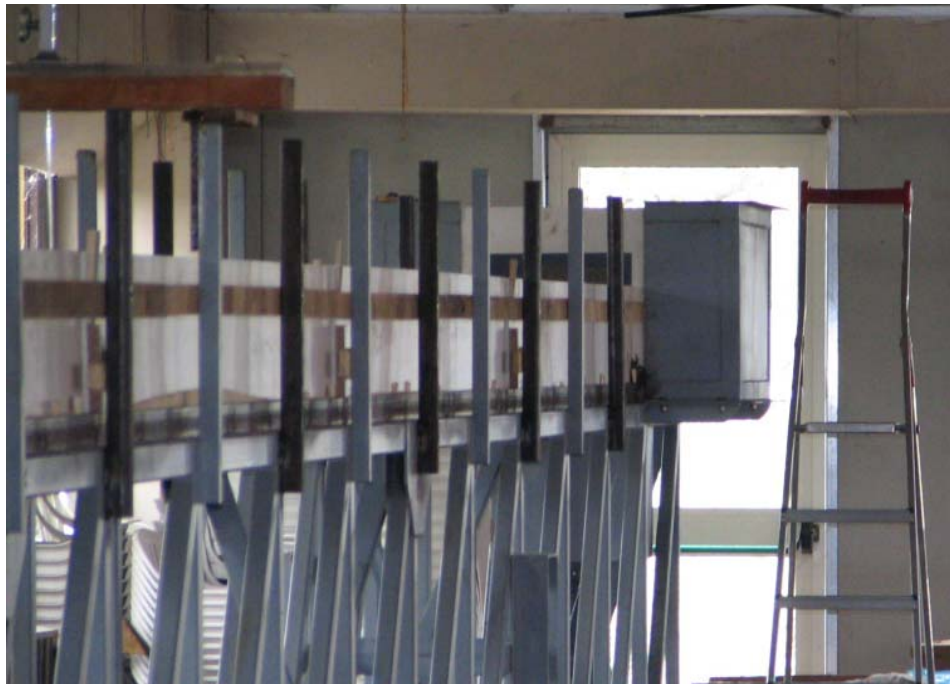
Figura 56: Fissaggio in testa delle sponde
