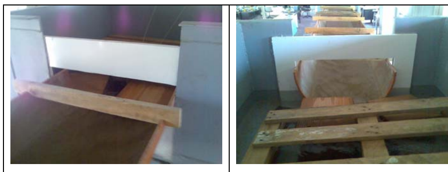
Figura 49: Particolare dell'imbocco dalla vasca di monte
