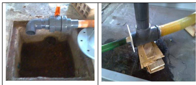
Figura 43: Particolare dello scarico e della "T"
