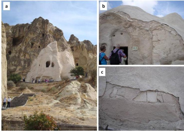
*Fig.1.6: Errati interventi consolidanti a base di cemento con evidenti alterazioni cromatiche (a) e fenomeni di fratturazione (b-c.)*
