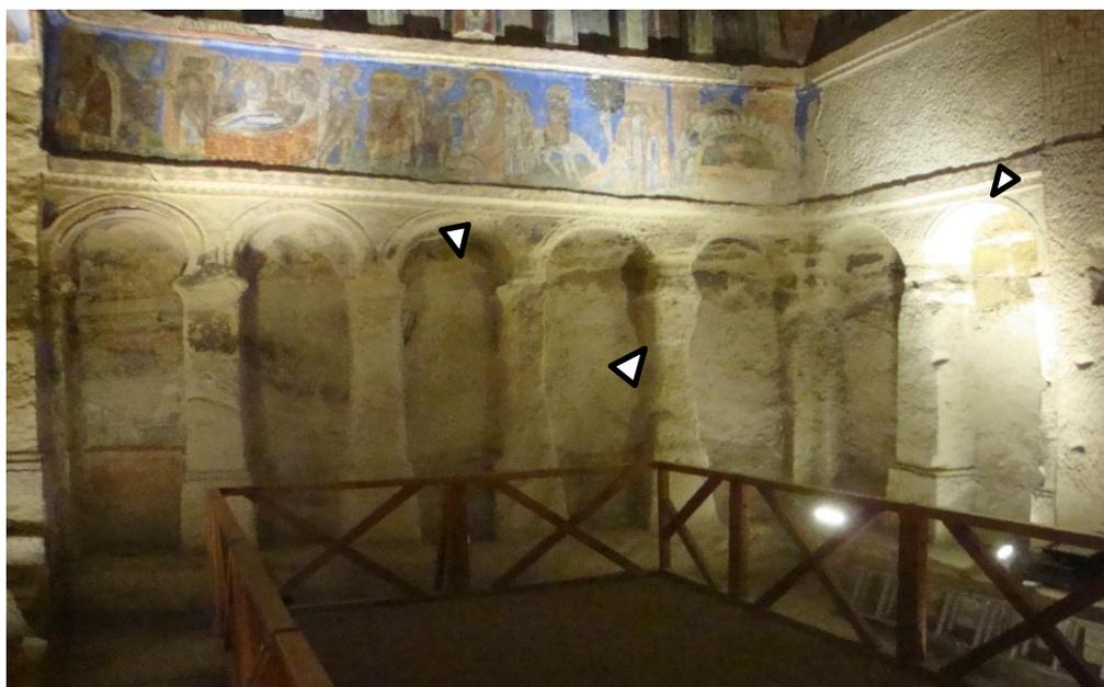
*Fig. 6.40: le frecce indicano le aree selezionate per l'applicazione dei consolidanti e delle stuccature. La scelta è ricaduta su punti interessati a fenomeni di scagliatura e decoesione.*
