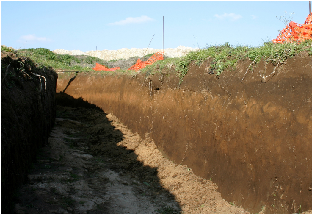
Fig. 3.12: Fosso di guardia ai margini dell'area S
