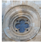
Fig. (5.3) Rosone facciata navate minori
