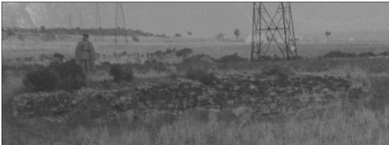
Fig. 3. Particolare con tratto del muro perimetrale sulla cui parte bassa si nota un intonaco duro, spesso alcuni centimetri, fatto di malta di calce e mattoni pestati.
