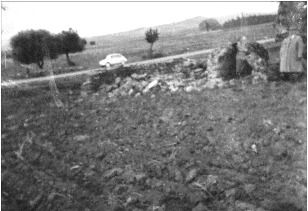
Fig. 13. Seconda vasca di decompressione e distribuzione, vista dall'interno, sita nella stessa parte alta del Piano del
