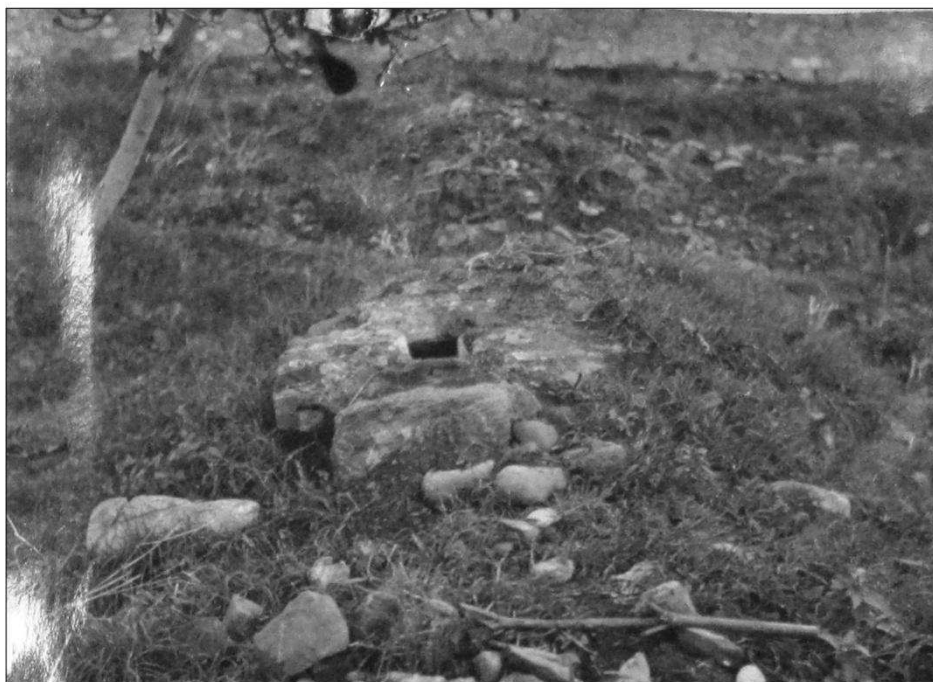
Fig. 26. Tratto di condotta lungo m. 6, scoperto nella Valle dei Greci a m 200 ad ovest, ma alla stessa altezza, dei ruderi descritti ai n. 22, 23 e 24. È una condotta incorporata in un muro, che, abbassatosi, ne ha interrotta la continuità sì che sulla foto si rendono visibili 2 fori, di diametro inferiore a quelli finora descritti; ma il foro superiore ha per base un elemento in terracotta simile a quelli che portano dalle sorgenti al serbatoio e qui sopra descritti al n. 25.
