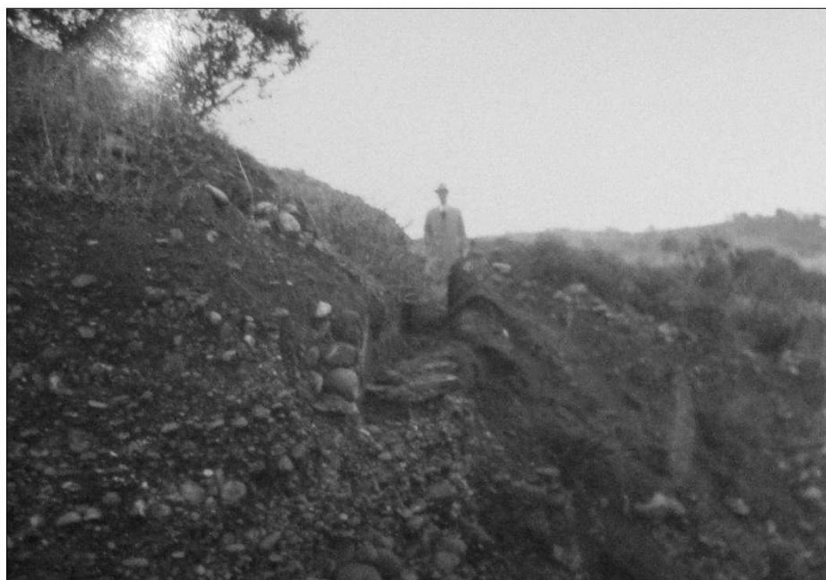
Fig. 8. Tratto di m. 6 del cunicolo di deflusso scoperto a 150 metri a valle della vasca serbatoio. Il cunicolo è di forma quadrangolare, poggia su roccia, è in lastricato ed ha i lati di circa 30 centimetri a valle, invece, del tratto di cunicolo fotografato se ne trova ancora affiorante da terra un ulteriore tratto di circa 2 metri. La costruzione della strada provinciale ne ha interrotta, a suo tempo, la continuità fino ai ruderi di una vasca di decompressione, le cui fondamenta si trovano, sotto strada, nell'ovile dell'Annunziata.
