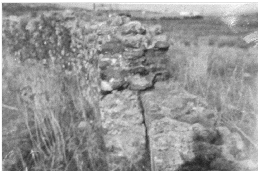
Fig. 6. Particolare della foto precedente, dal quale si rileva la duplicità del muro perimetrale, che ha lo spessore complessivo di m. 1,20.
