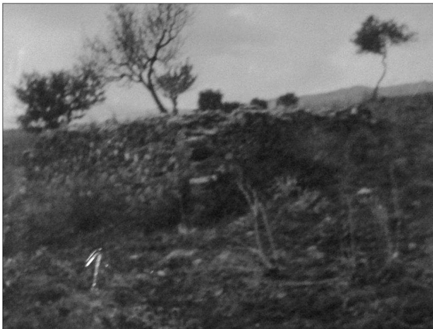
Fig. 10. Vasca di decompressione e distribuzione sita sulla parte alta del piano del Barco e delle Cappelluzze: è di forma rettangolare con il lato maggiore di m. 6 e quello minore di m. 3,70: ha muri alti circa m. 2, dallo spessore di oltre 60 centimetri, ed è pavimentata in lastricato. Presenta una zona di intonaco simile a quello della grande vasca-serbatoio e, sul muro inferiore, un forame di deflusso, indicato dalla freccia. Dista circa un chilometro dalla vasca serbatoio.
