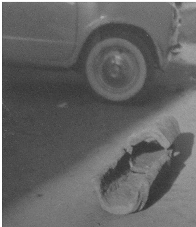
Fig. 25. Elementi in terracotta della condotta, che dalle sorgenti porta al serbatoio: hanno la lunghezza di cm. 50; lo spessore di cm. 3-4; la larghezza di cm. 14 di vuoto; l'altezza di cm. 13; hanno forma quadrangolare gli inferiori e triangolare i superiori; sono forniti agli estremi di due perfetti incastri. Dopo giustapposizione hanno una portata di oltre cm 2 150 di superficie; sono ricoperti all'interno di un'incrostazione calcarea dello spessore di oltre un centimetro, incrostazione, che, come gli incastri, appena si intravede nella foto.
