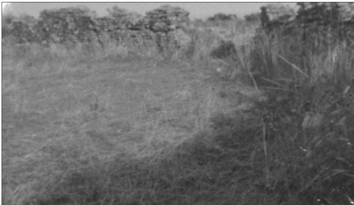
Fig. 5. Altro settore del muro perimetrale della vasca serbatoio.
