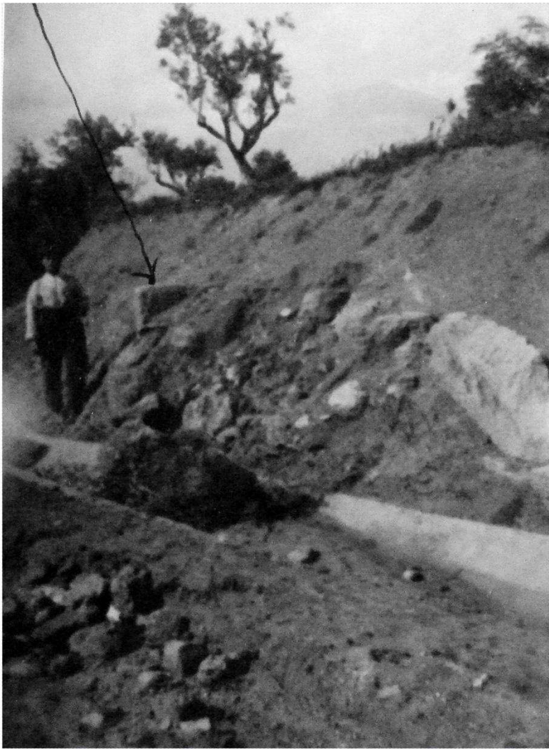
Fig. 5. Sopralluogo in località Marcellina (1929). La freccia indica “angolo del muro attraversato dalla strada e coperto dal terrapieno” . Segnalato con A nella relazione di E. Galli. Gabinetto fotografico della R. Soprintendenza per le Antichità e l'Arte del Bruzio e della Lucania. Reggio Calabria n. 1720. Vedi documento n. 41.
