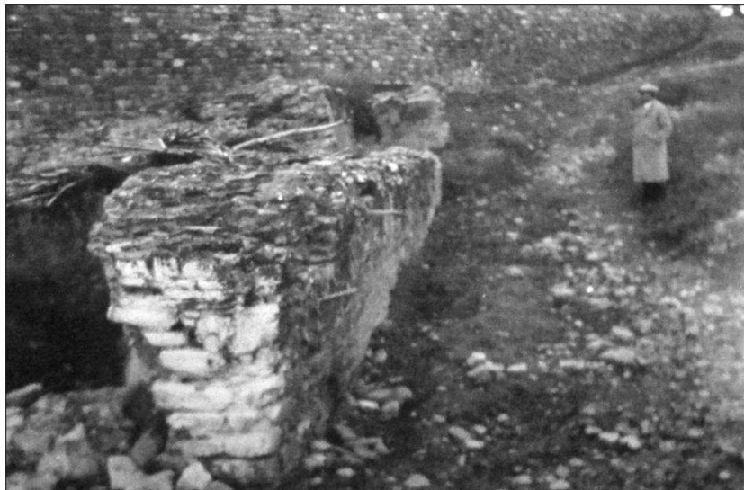
Fig. 20. Lo stesso muro lungo, di cui si vede la curvatura del lato dell'intonaco.
