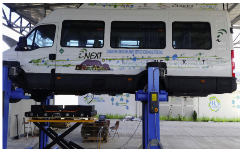
Figura 4.8: Installazione pacco batterie (BES)
