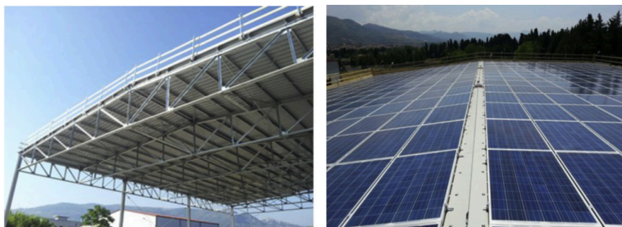
Figura 4.16: Impianto fotovoltaico da 100 kW
