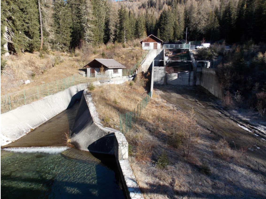
Fig. 5-18 Stazione di monitoraggio ARPAV, sita in località Mondeval di Sotto (Selva di Cadore).
