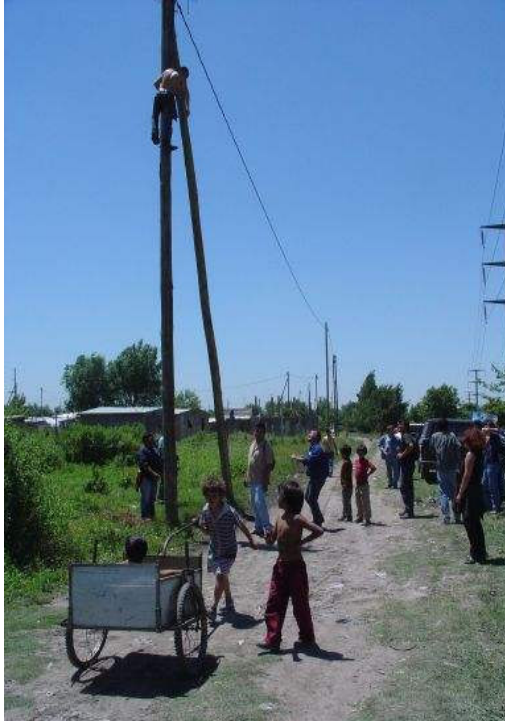
Immagine3: Installazione dell'antenna Tv piquitera
