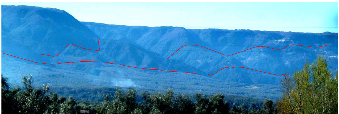
Figura 75 Panoramica da ovest dei rami di faglia appartenenti alla struttura principale definita in letteratura Faglia di Cittanova.
