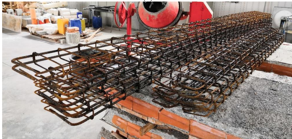
Figura 4.1 - Barre di acciaio interne: (a) distinta armatura gruppo di travi A e B (misure in mm); (b) gabbie assemblate prima del getto.
