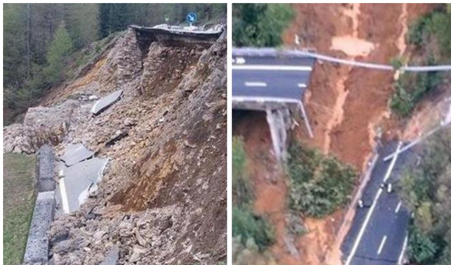
Fig. 3.41 - Strada di accesso al comune di Prato allo Stelvio (BZ) non percorribile a causa di uno smottamento (maggio 2018) e autostrada A6 Torino-Savona interrotta per crollo di un viadotto in seguito a una frana (novembre 2019).
