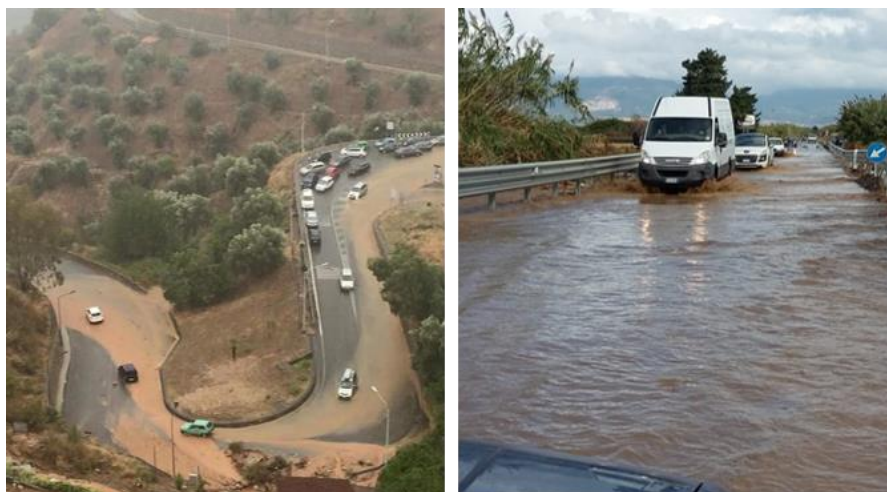
Fig. 3.39 - Strade non percorribili in seguito ad alluvioni. (Rossano (CS), agosto 2015 e Lamezia (CZ), ottobre 2018).
