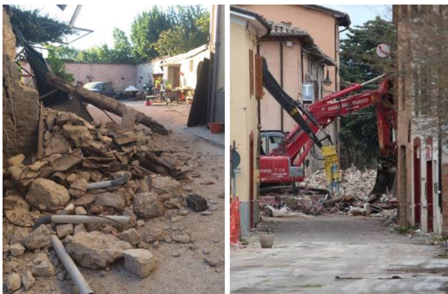
Fig. 3.17 - Strade interrotte per il collasso di alcune strutture in seguito a terremoti (Norcia (PG), agosto 2016 e Macerata, aprile 2018).
