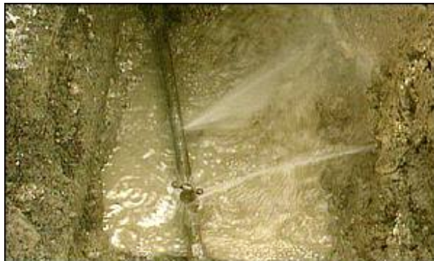
Figura 1.10 - Fughe da una condotta
