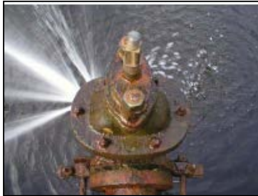
Figura 1.9 - Perdita di una giunzione
