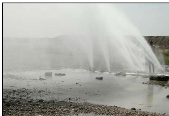
Figura 1.11 - Rottura di una condotta
