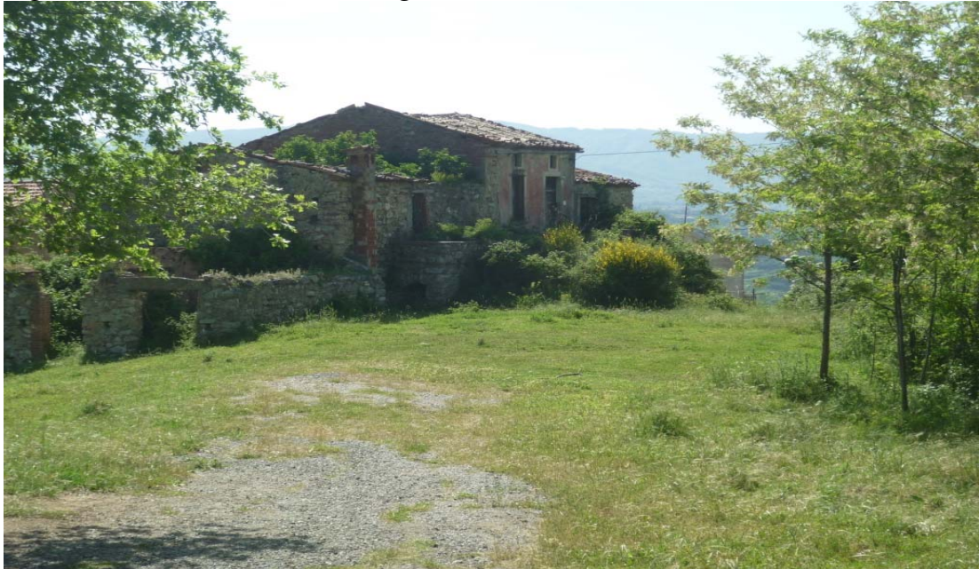
Fig. 9.7 - Abitazioni rurali in degrado
