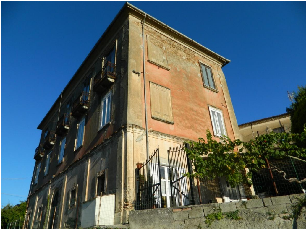
Figura 52. Palazzo Mirabelli in Carpanzano. Fonte: Comune di Carpanzano.
