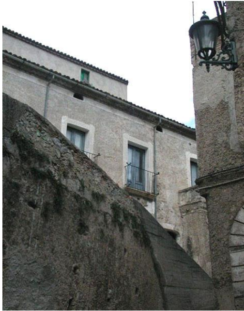
Figura 73. Civita. Palazzo Placco prima della ristrutturazione.
