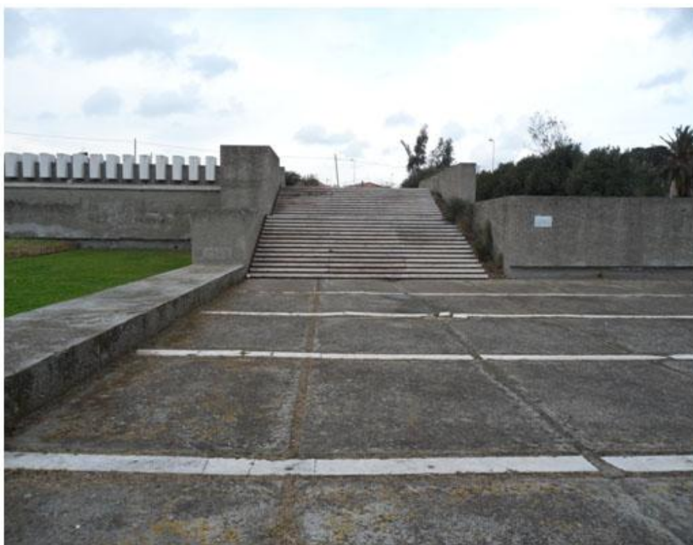
Figura 313. Crotona. Monumento ai Fratelli Bandiera. In evidenza la scalinata in marmo che porta al secondo livello.
