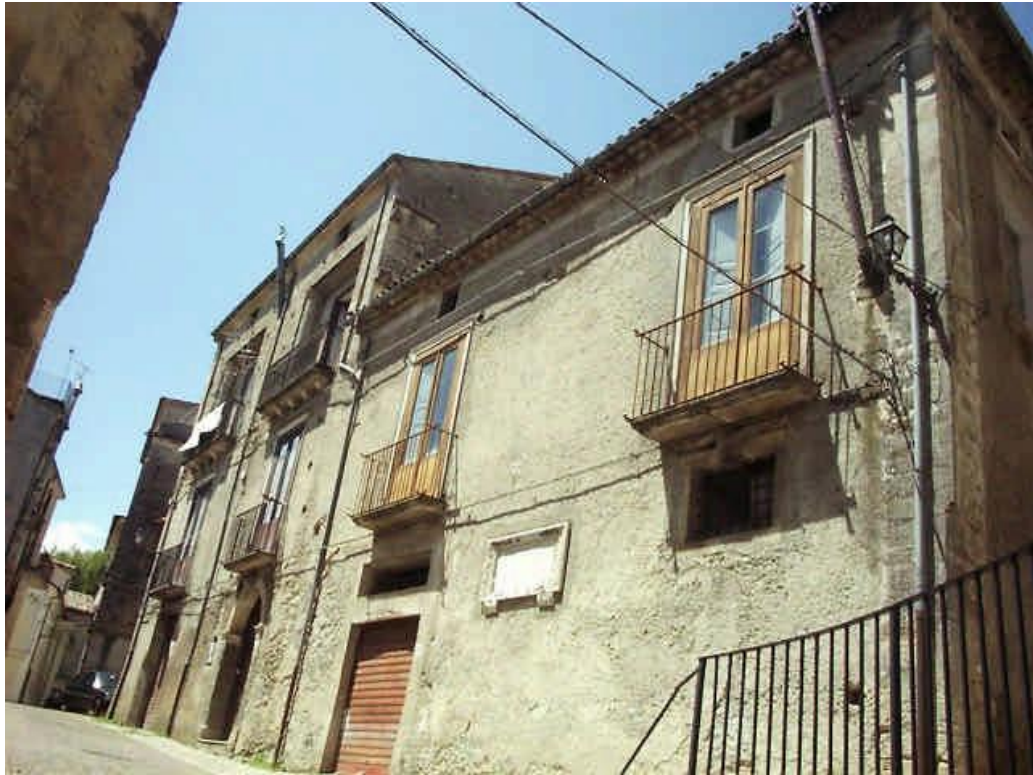
Figura 110. Palazzo Stancati. Il Palazzo è su tre livelli. Al piano terra il portale è in pietra; ai lati ci sono due finestre con cornice in pietra. Al primo piano sono presenti tre balconi in ferro battuto lavorato. Al secondo piano ci sono tre balconi in ferro battuto semplice.
