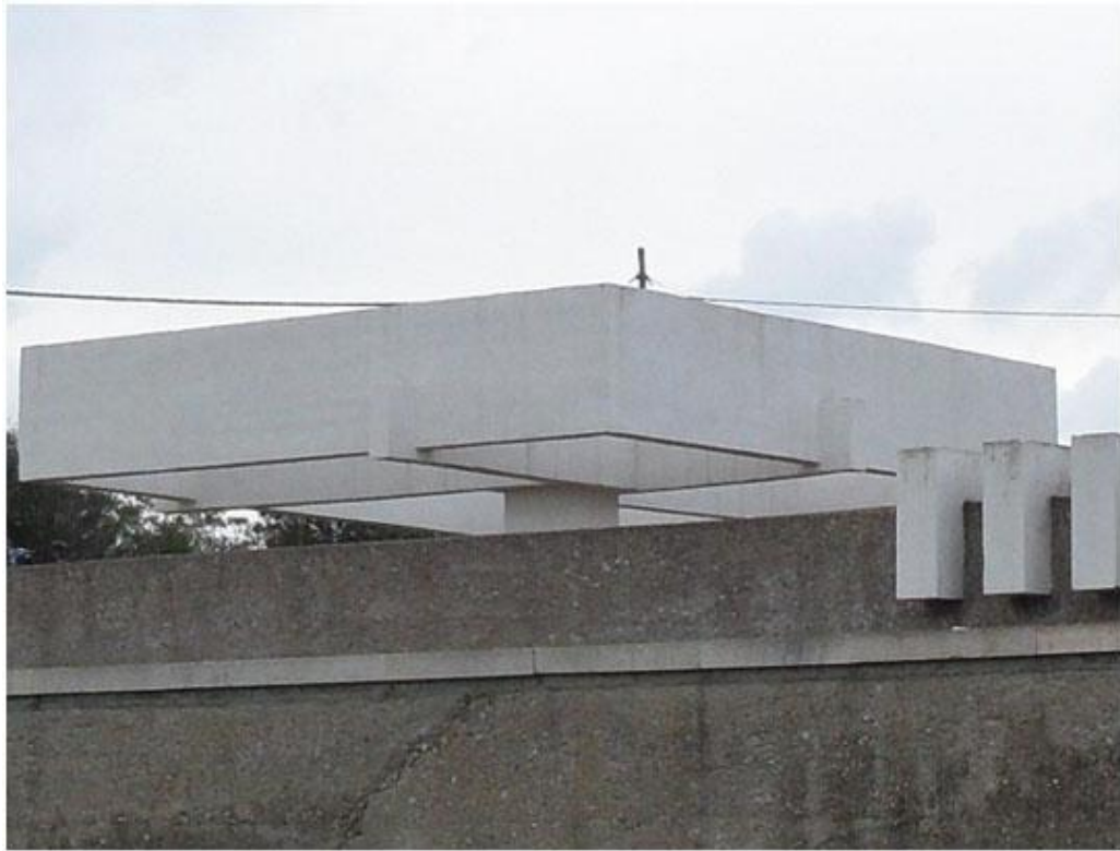
Figura 315. Crotona. Monumento ai Fratelli Bandiera. Livello superiore: struttura in calcestruzzo alta circa tre metri, un parallelepipedo sorretto da un pilastro decentrato verticale e posto nel punto d'incontro di due travi che si intersecano perpendicolarmente.
