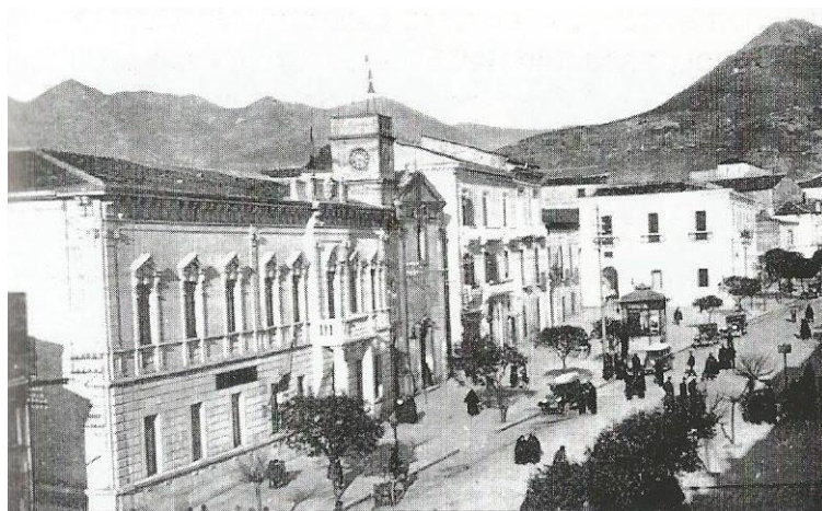
Figura 63. Castrovillari. Corso Garibaldi, lato nord. Fonte: Sitongia, 2011.
