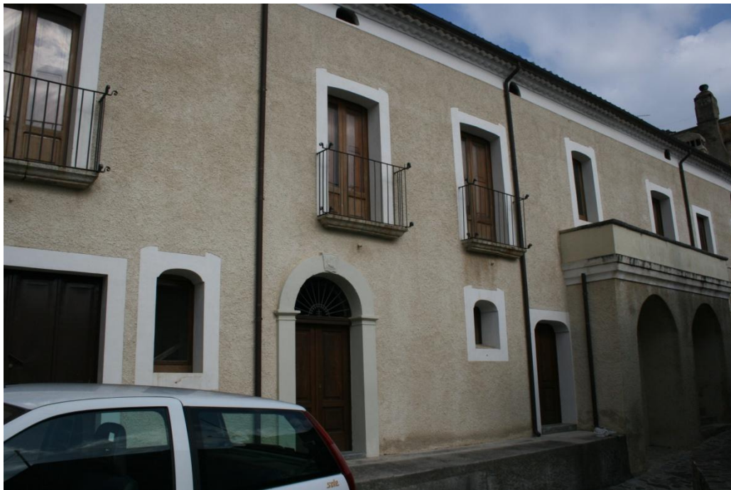
Figura 74. Civita. Palazzo Placco dopo la ristrutturazione.
