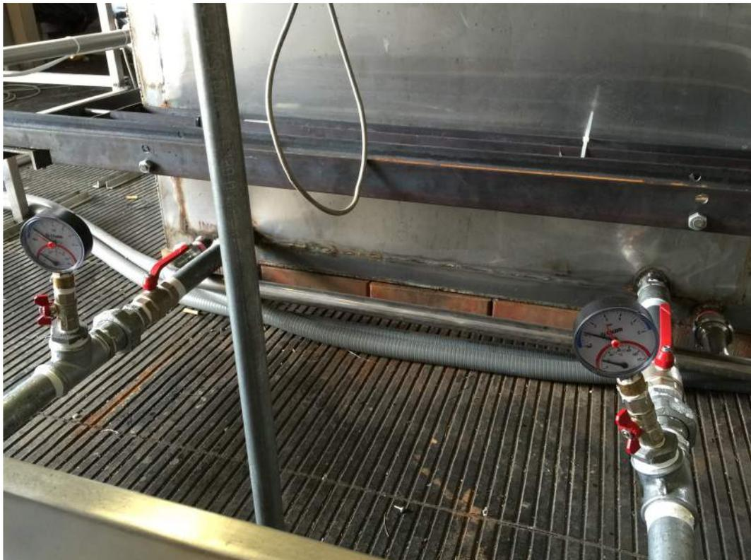
Figura 4.13: Termomanometri dello scambiatore
