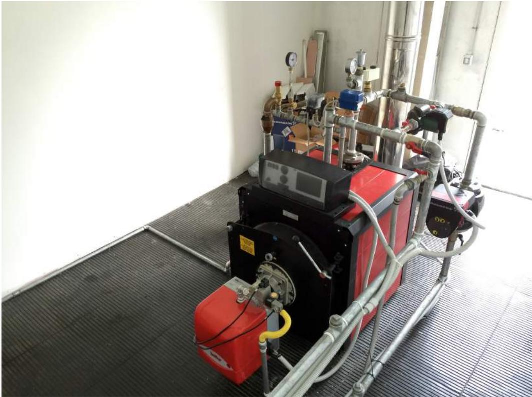
Figura 4.2: Caldaia dell'impianto termico
