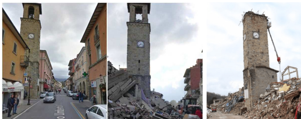
Amatrice: torre civica prima del terremoto, dopo la scossa del 24 agosto e a seguito dell'evento del 30 ottobre.
