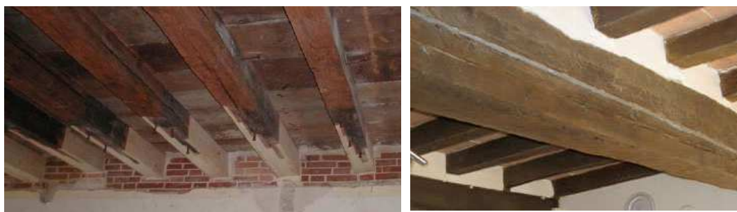
Recupero dei solai: sostituzione delle teste delle travi (a sinistra) e ripristino della sezione resistente (a destra).
