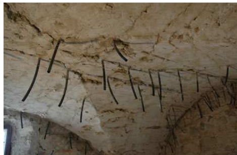
Recupero dei solai voltati: inserimento frenelli (a sinistra) e iniezioni dall'intradosso (a destra).
