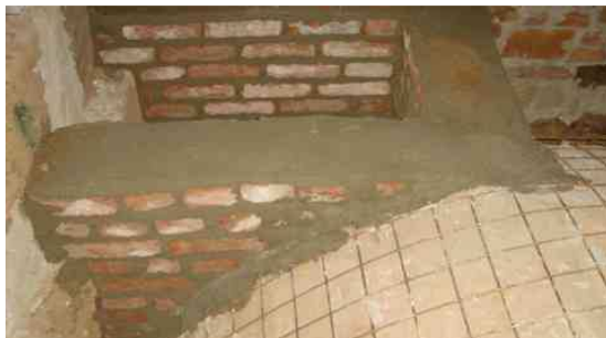
Recupero dei solai voltati: inserimento frenelli (a sinistra) e iniezioni dall'intradosso (a destra).
