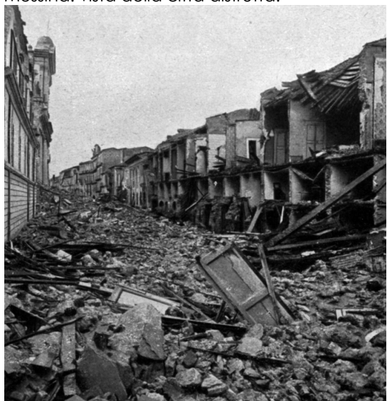
Messina: edifici distrutti in via Cardines.
