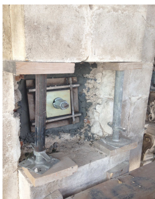
Inserimento di tiranti: tecnica di messa in opera (a sinistra) e coefficienti correttivi proposti dalla NTC 2008 (a destra).
