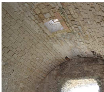
3.a Volte in blocchi di pietra
