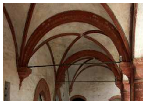
Recupero dei solai voltati: cattura dall'estradosso (a sinistra) e inserimento di catene (a destra).
