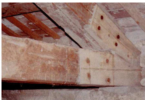
Recupero delle capriate: sostituzione delle teste travi (a sinistra) e inserimento delle fasce in acciaio (a destra).
