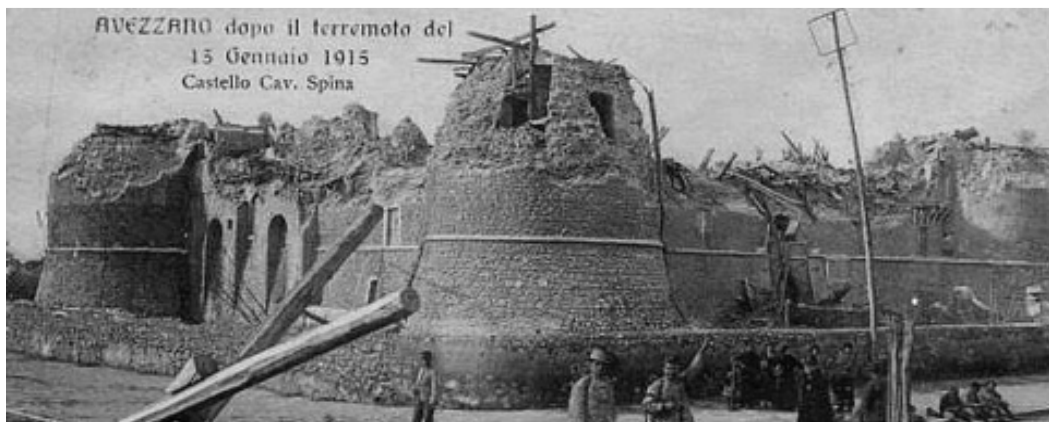
Avezzano: il castello Orsini prima e dopo il sisma.
