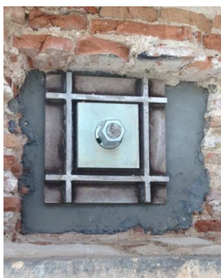
Inserimento di tiranti: tecnica di messa in opera (a sinistra) e coefficienti correttivi proposti dalla NTC 2008 (a destra).
