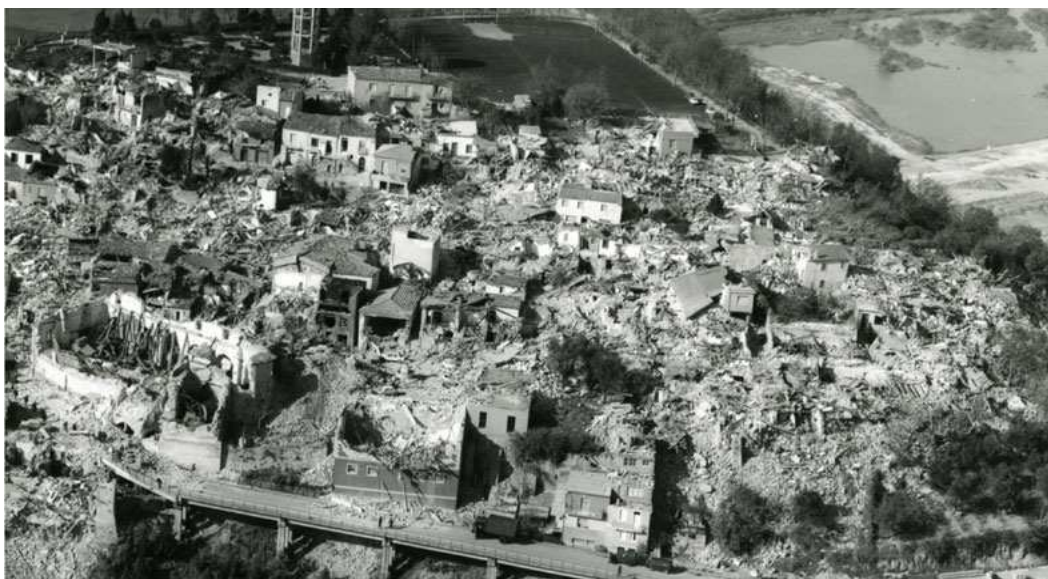
Sant'Angelo dei Lombardi: veduta e vista aerea del centro dopo il sisma.
