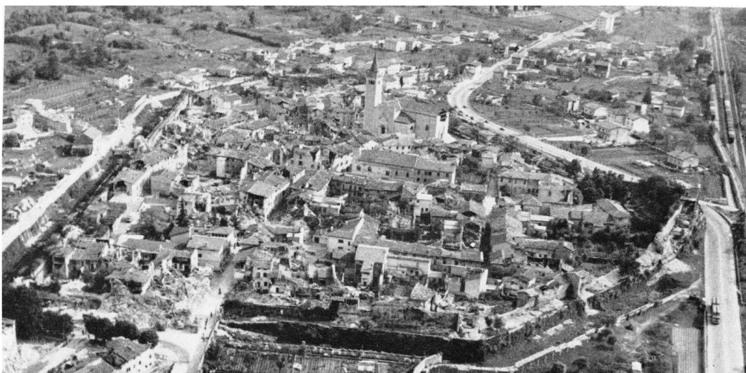
Terremoto del Friuli: vista di Venzone dall'alto.
