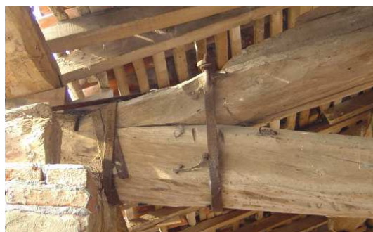
Recupero delle capriate: sostituzione delle teste travi (a sinistra) e inserimento delle fasce in acciaio (a destra).
