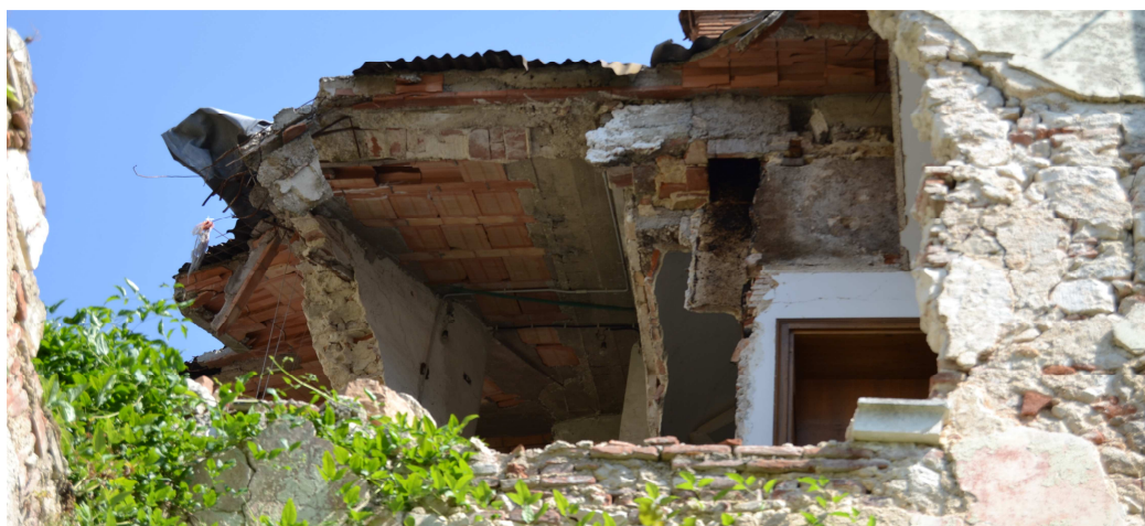
L'Aquila: effetti del tetto pesante sulle murature d'ambito.
