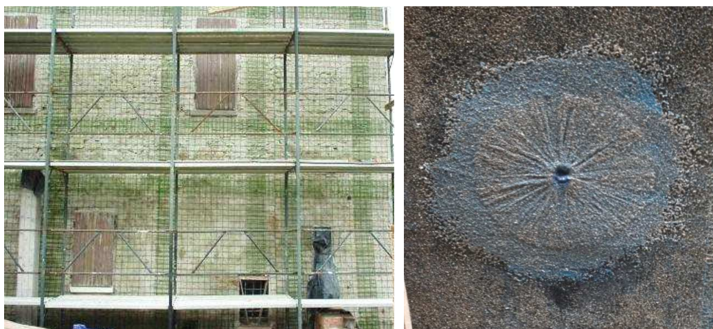
Realizzazione di cerchiature esterne: applicazione sull'intera facciata (a sinistra) e particolare costruttivo (a destra).
