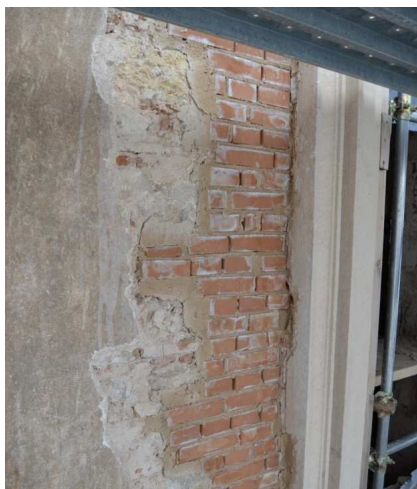
Tecniche di consolidamento dei paramenti murari: scuci e cuci (a sinistra) e cordolo in muratura armata di sommità (a destra).
