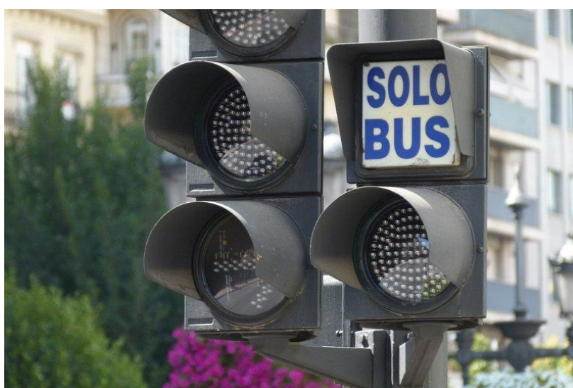
Figura 5 - Impianto semaforico a priorità per il servizio di trasporto pubblico
