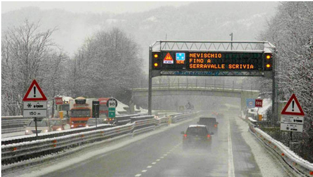
Figura 2 - Pannello a messaggio variabile in autostrada
