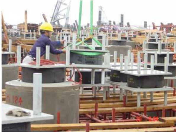
**Fig. 1.16. I due serbatoi LNG da 140,000 m<sup>3</sup> in costruzione ciascuno protetto con 360 HDRB nel 2006.**
