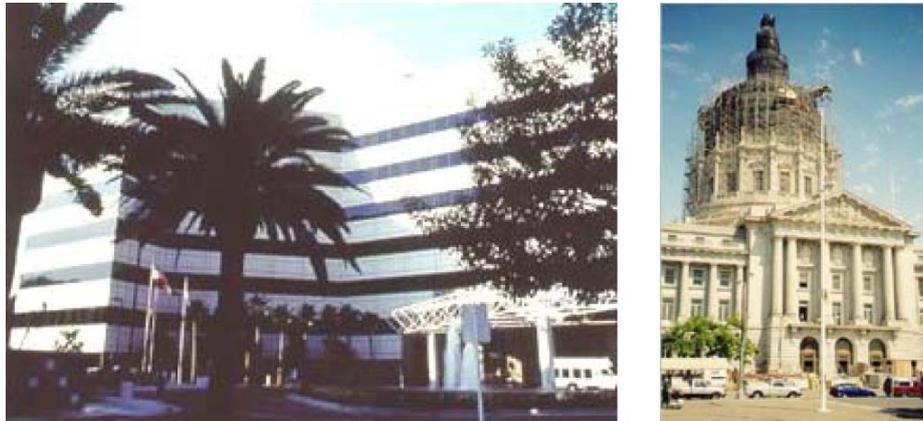
**Fig. 1.10. A sinistra: l'USC Hospital di Los Angeles, protetto da LRB, A destra: il Municipio di San Francisco, costruito nel 1912, danneggiato dal terremoto di Loma Prieta del 1989 ed adeguato sismicamente con 530 LRB e 62 SD nel 2000.**
