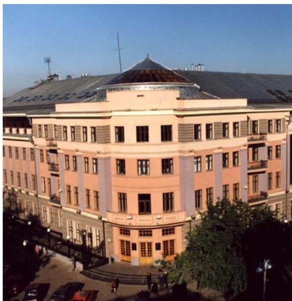
**Fig. 1.13. La Banca Centrale di Irkutsk, adeguata sismicamente con HDRB.**
