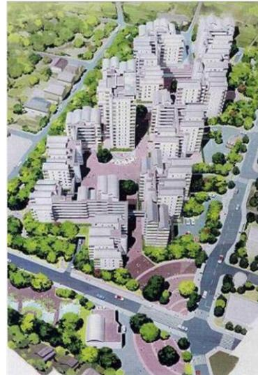
**Fig. 1.11. A sinistra: Edificio di 87,4 m d'altezza, che fu isolato sismicamente a Tokyo nel 2000. A destra: Schizzo del complesso di 21 edifici di 6÷14 piani che sorgono tutti su un'unica piattaforma isolata sismicamente a Sagamihara, nell'area di Tokyo.**
