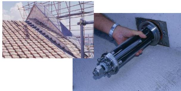
(b) Protezione sismica della Basilica di S. Francesco (Assisi): Schema del collegamento tra tetto e parete mediante dispositivi in lega a memoria di forma.
