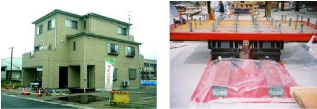
**Fig. 1.12. Villetta giapponese protetta da isolatori a ricircolo di sfere in acciaio.**
