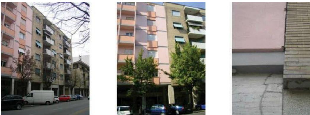
Figura 2.16 – Viste delle facciate principali degli edifici e dettaglio del giunto di separazione.
