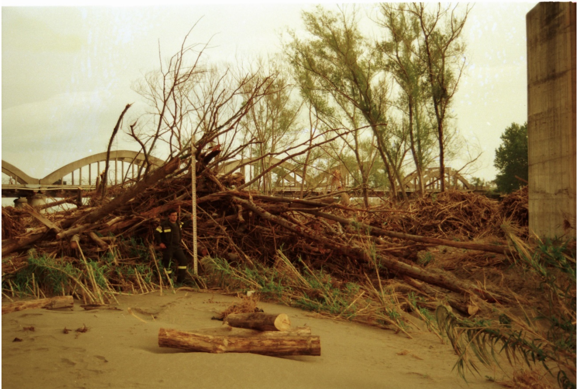
Figura 57-Immagine con vista verso valle da sotto il ponte della SS106. Visibile presenza massiccia di vegetazione (per gentile concessione di F. Macchione)
