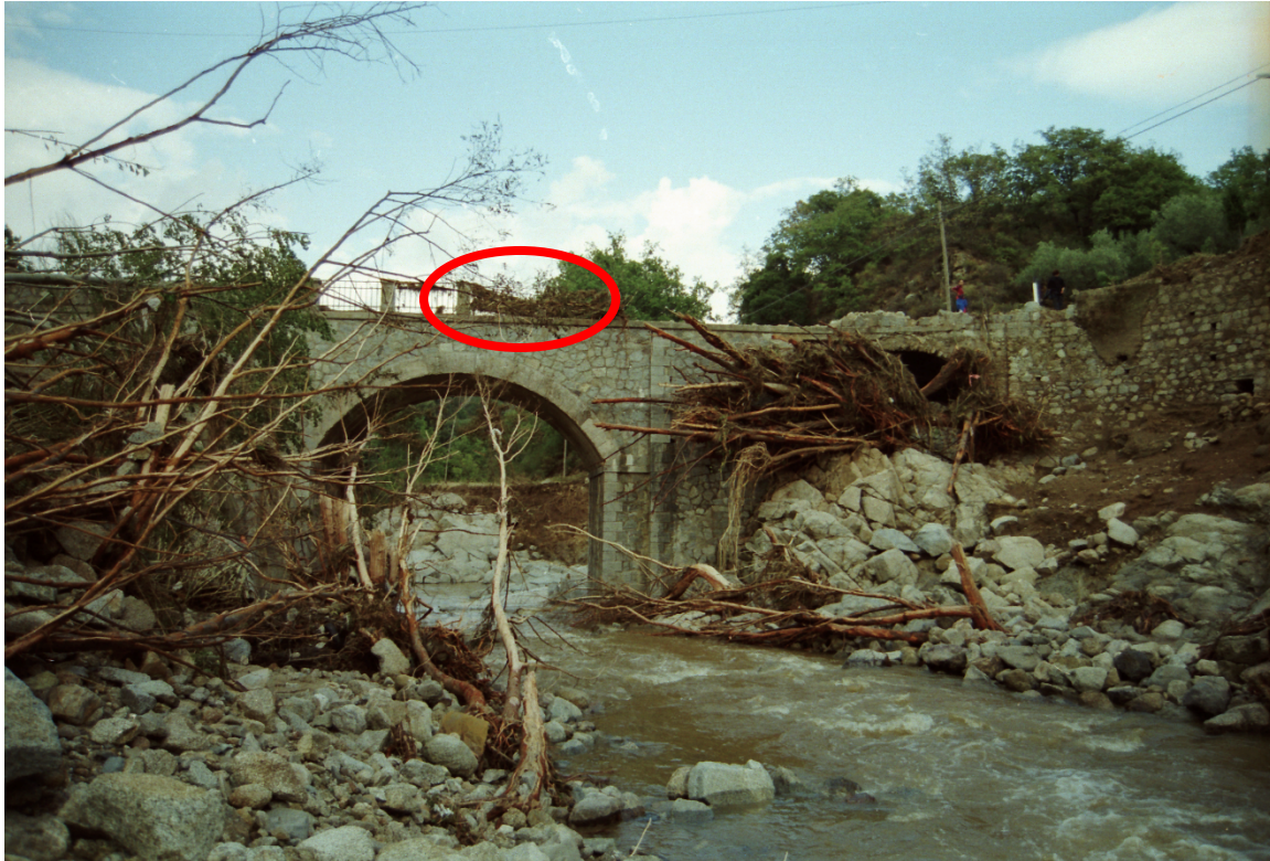
Figura 66-Ponte di Petrizzi post evento vista verso valle – visualizzazione segni di tracimazione (per gentile concessione di F. Macchione)
