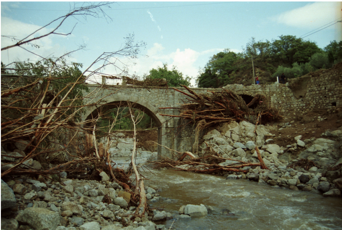
Figura 64-Ponte di Petrizzi post evento vista verso valle (per gentile concessione di F. Macchione)
