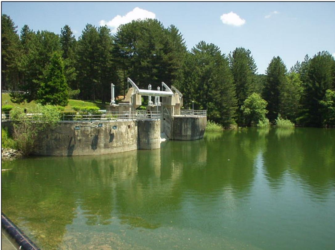
*Figura 4.9 : Vista dello scarico di superficie*
