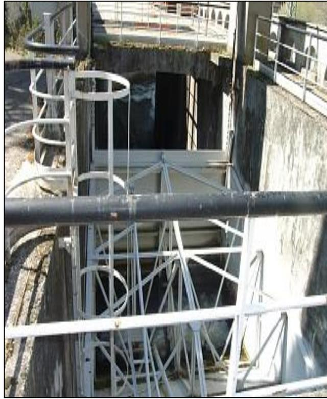
*Figura 4.30 : Vista della paratoia di regolazione del canale di scarico*
