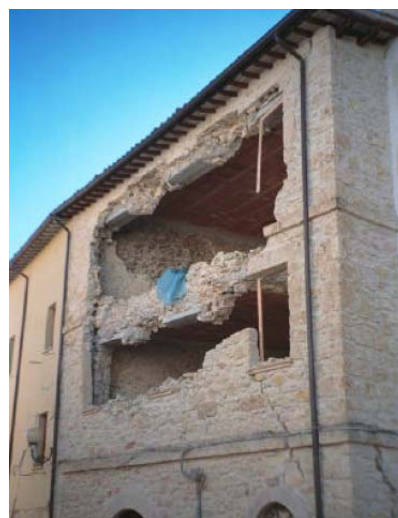
Fig. 3.1: Esempi di meccanismi di collasso di pareti murarie. -a Ribaltamento globale di una parete esterna; -b: Ribaltamento globale di una parete di testata; -c: Ribaltamento parziale.
