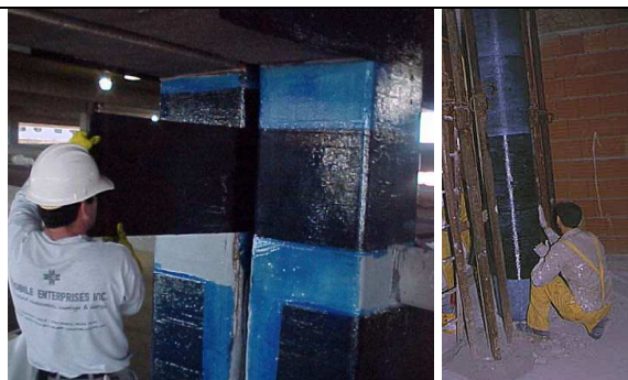
Fig.1.9 – Intervento di confinamento
