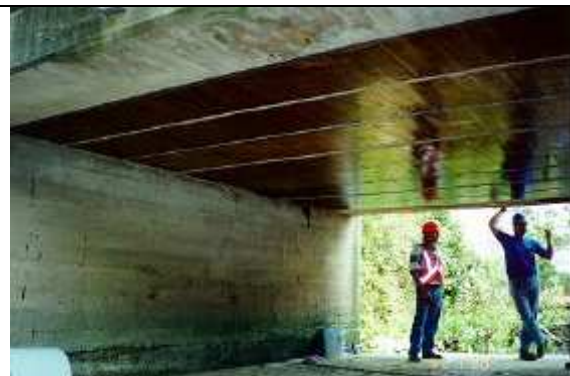
Fig.1.8 – Intervento di rinforzo a flessione
