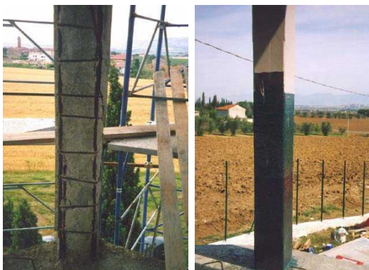
Fig.1.15 - Serbatoio di Castiglione del Lago (PG): foto prima e dopo l'intervento di fasciatura
