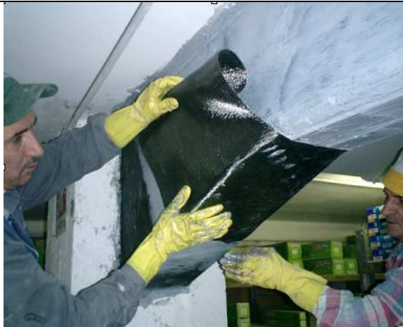
Fig.1.6 – Intervento di rinforzo a taglio
