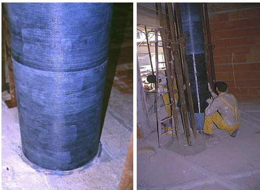
Fig.1.14 - Coop centro storico di Milano: intervento di fasciatura di un pilastro
