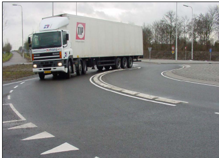
Figura 7.12: Cordoli all'anello in una Turborotatoria olandese [7.3]
