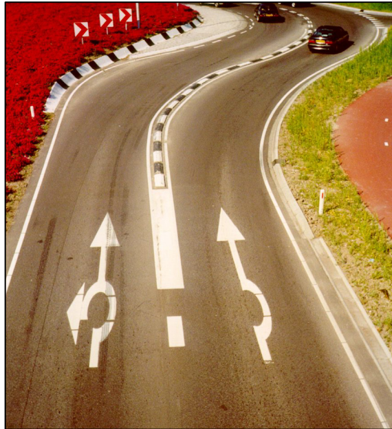
Figura 7.11: Cordoli e segnaletica orizzontale in una Turborotatoria olandese [7.1]
