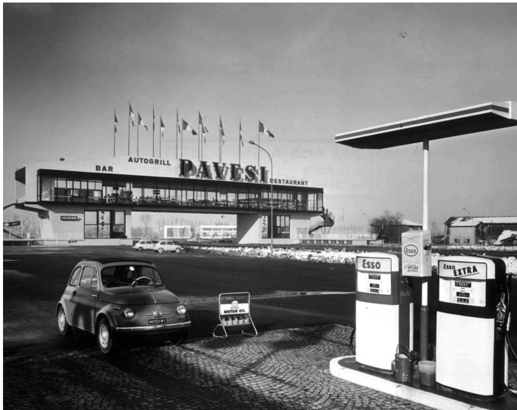
Fig. 87 - Il piazzale dell'area di Fiorenzuola d'Arda con l'autogrill Pavesi, Autostrada del sole, 1959, prog. A. Bianchetti (AAB)
