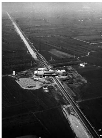
Fig. 98 - Il cantiere di un autogrill Pavese (AAB)
