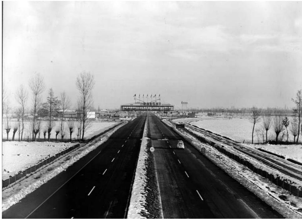
Fig. 101 - L'autogrill Pavese di Fiorenzuola d'Arda (AAB)
