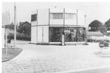
Fig. 27 - Il prototipo di Jean Prouvé per la stazione prefabbricata della Total, 1967
