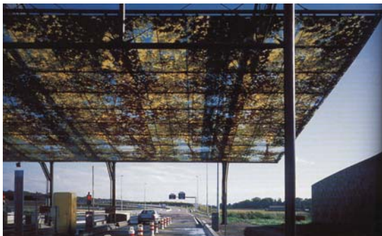
Fig. 154 - La barriera di Coté Picard, sull'autostrada A6, Francia, 1999, prog. Manuelle Gautrand
