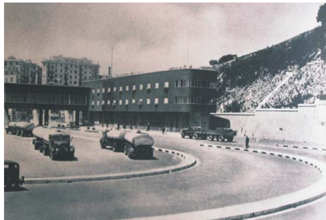
Fig. 47 - La stazione di barriera di Genova sulla Genova - Serravalle
