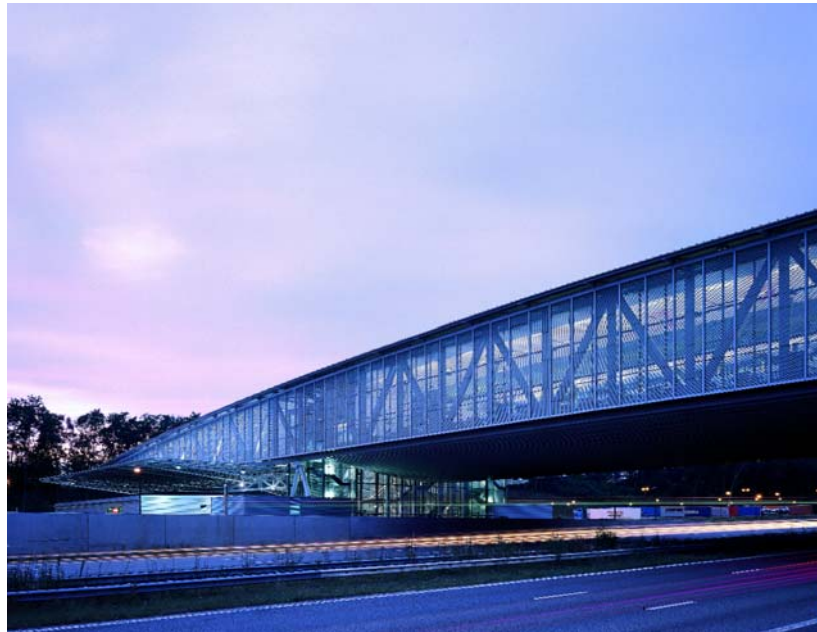
Fig. 138 - L'edificio a ponte nell'area di servizio di Nivelles, Belgio, sulla E-19 Bruxelles - Parigi, prog. Samyn & partners, 1998-2001(Samyn & partners)
