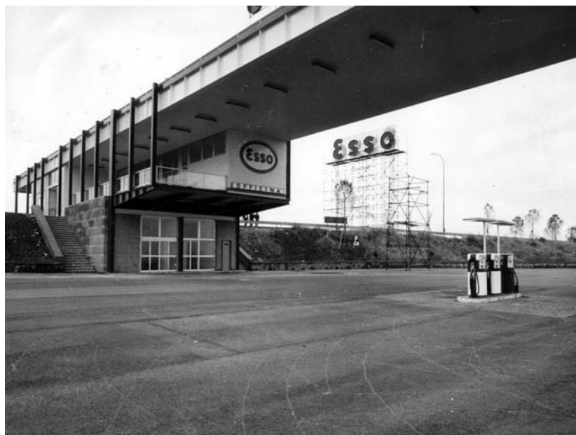
Fig.93 - 94 La stazione di servizio Esso nell'area di Frascati, prog. A. Bianchetti (AAB)
