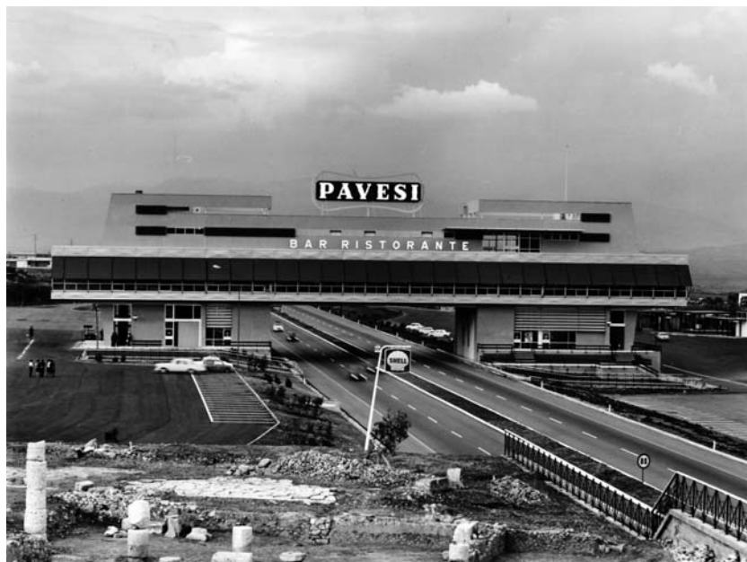
Fig. - 95 L'autogrill di Feronia, Autostrada del sole, 1964, prog. A. Bianchetti (AAB)
