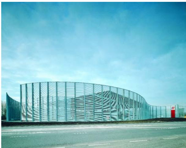
Fig. 133 - La barriera frangivento nella stazione di Houten, Olanda, 2000, prog. Samyn & partners (Samyn & partners)
