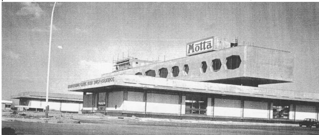
Fig.120- Il Mottagrill di Limena (AMB)
