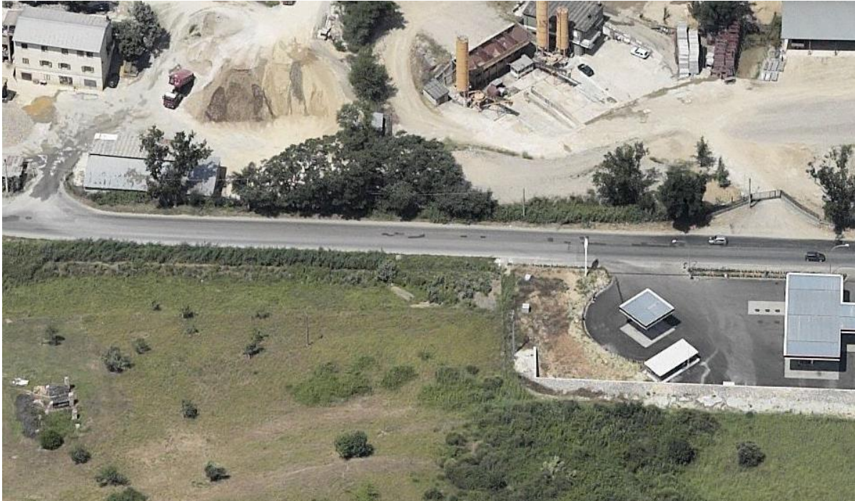
Figura 4.3.1.1 Sito di test
