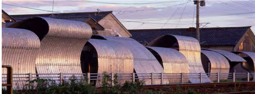
Figura 1 Le forme ripiegate in lamiera producono cavità acustiche differenziate, Shuhei Endo, Transtation, 1996
