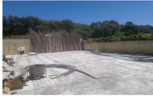
**Figura 73- Pendio che porta l'acqua alla cisterna** **Figura 74- Tetto della cisterna in costruzione**
