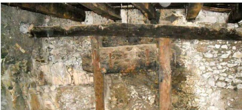
*Particolari di utilizzo del legno. Dall'alto: solaio di copertura, solaio intermedio e solaio cantina.*
