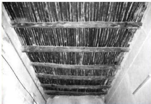
*Esempio di solaio campano con travi principali e orditura secondaria (panconcelli) (immagine tratta da A. BOSCO, Presentazione architettura rurale potenzialità/innovazione/sviluppo).*
