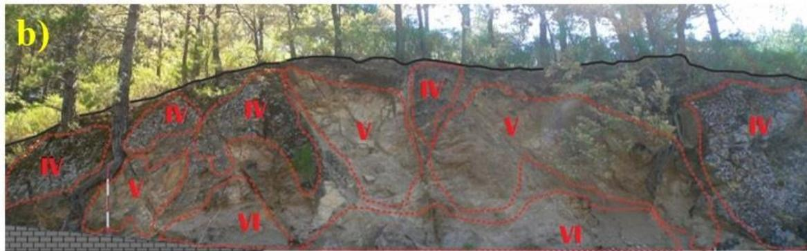
Fig. 2.5- (a) Rilievo delle discontinuità strutturali presenti sul fronte ; (b) Delimitazione preliminare delle zone a diverso grado di alterazione.
