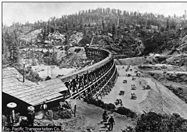
Fig. 1.1: I lavori della Central Pacific Railroad in Sierra Nevada nel 1864 (fonte So. Pacific Transportation Co.)
