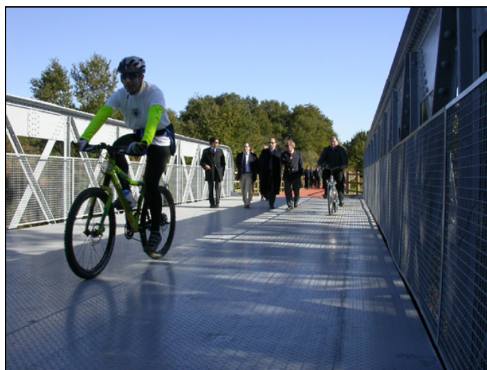
Fig. 4.9 : Ponte nei pressi del Rio Manco (Friestas)
