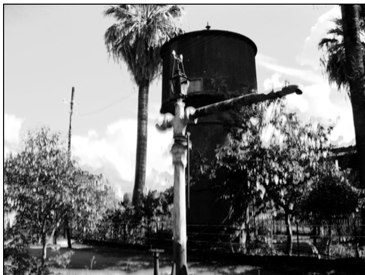
Fig. 1.16 : Serbatoio pensile nei pressi della vecchia stazione di Rende (CS)
