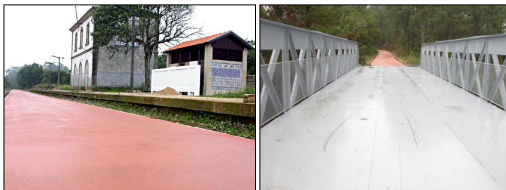
Fig. 4.21 : Stazione nei pressi di Monção Fig. 4.22 : Ponte in acciaio alle porte di Monção
