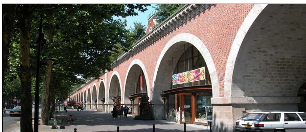
Fig. 4.39 : La galleria commerciale sotto le arcate di Viaduc Daumesnil
