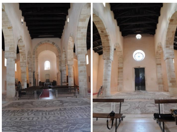
Figura 3.2. Vista interna della Chiesa.
