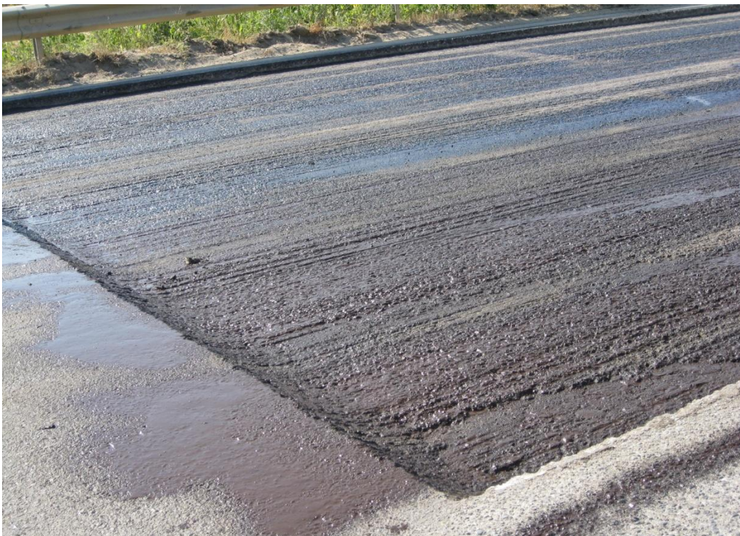
Fig.7.9 (h) - Preparazione delle superfici di stesa
