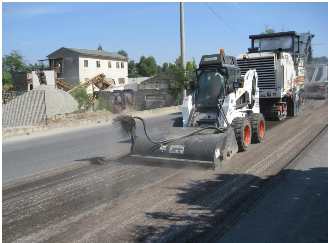
Fig. 7.9 (b)- Fresatura strati superficiali
