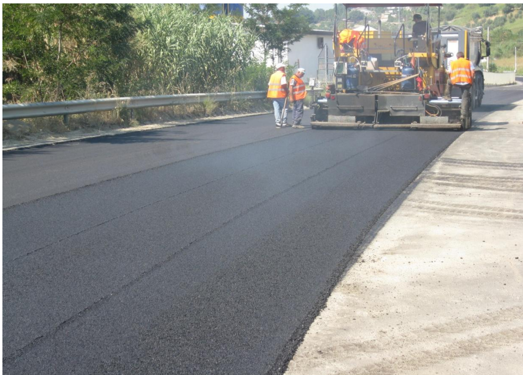
Fig.7.9 (l) - Posa in opera degli strati superficiali
