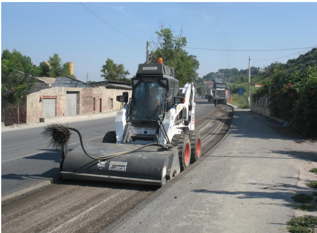
Fig. 7.9 (f) – Pulitura del piano di posa
