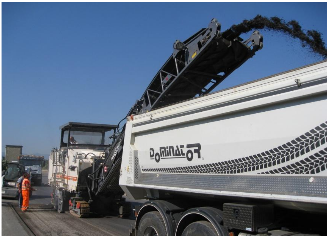
Fig. 7.9 (d)- Fresatura strati superficiali
