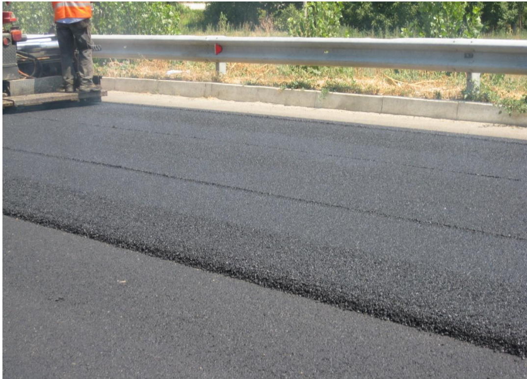
Fig.7.9 (i)- Posa in opera degli strati superficiali
