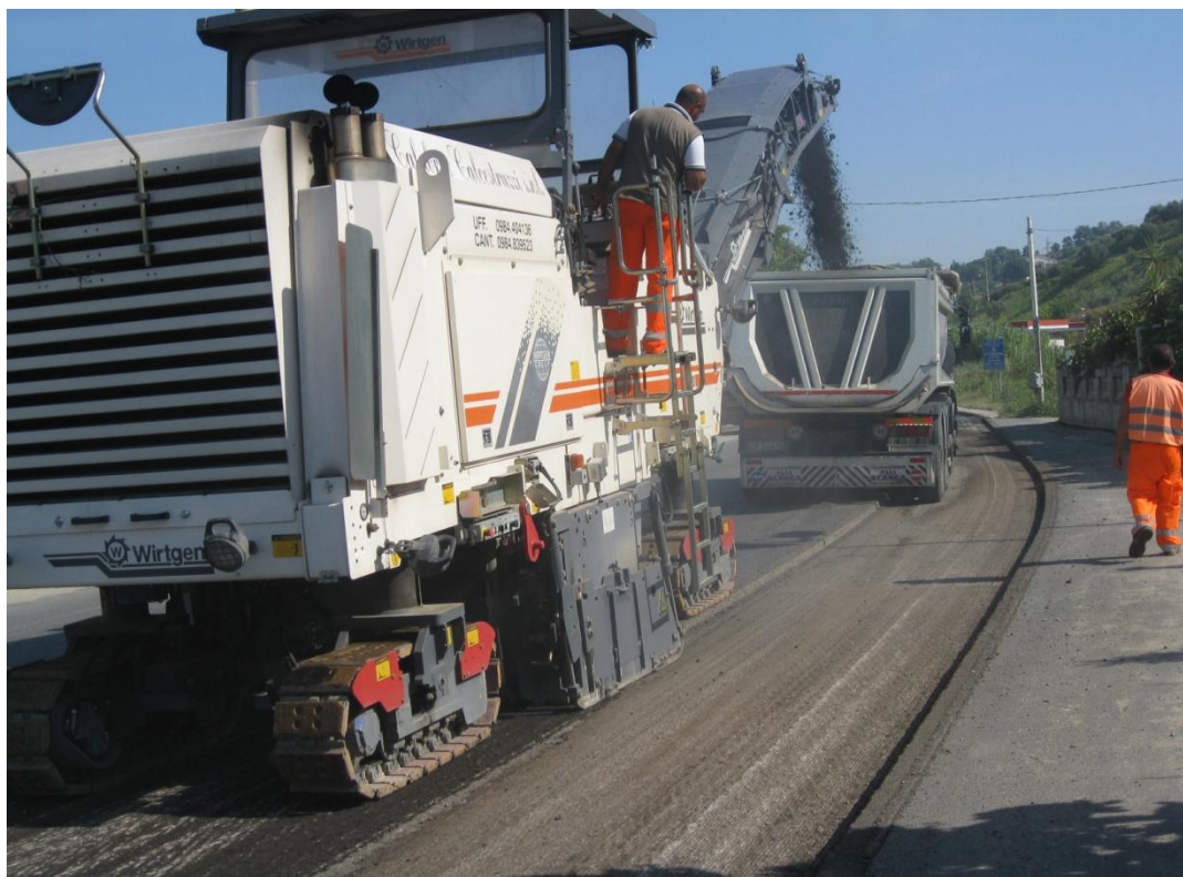
Fig. 7.9 (a) - Fresatura strati superficiali
