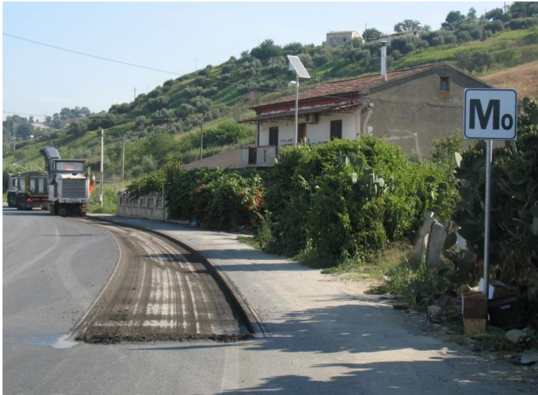
Fig. 7.9 (c)- Fresatura strati superficiali
