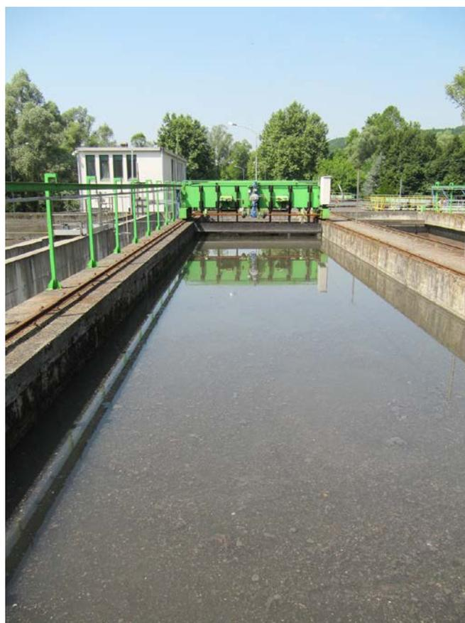
Figura 5.3: Vasca di Sedimentazione con Pianta Rettangolare (<http://www.valbeservizi.it>).
