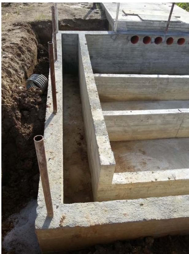
**Figura 5.32:** Canale di scolo delle acque all'uscita del pacchetto filtrante.
