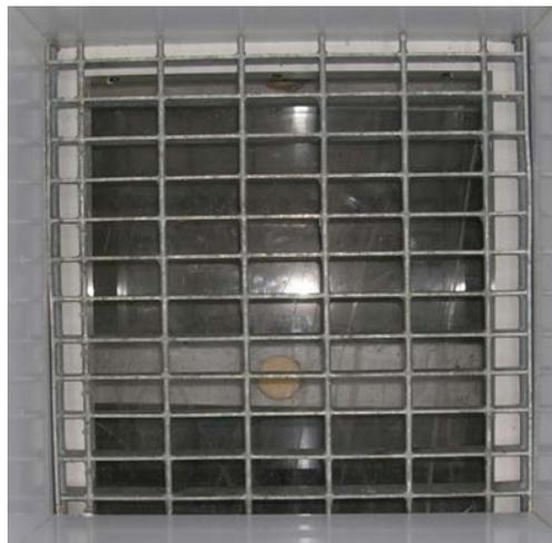
**Figura 4.28: Griglia alla base dell'unità filtrante.**
