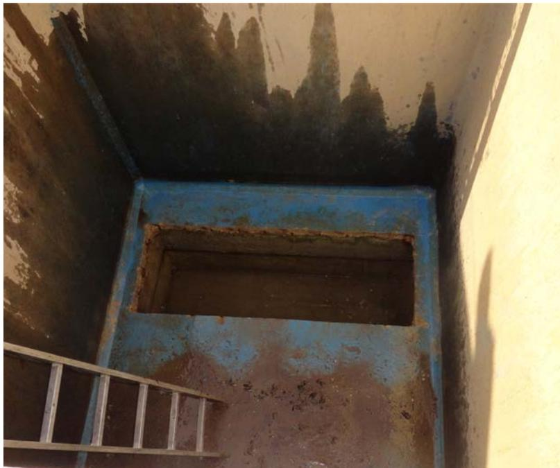
Figura 5.27: Tramoggia all'interno della vasca di sedimentazione.
