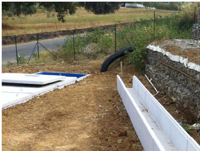
**Figura 5.23:** Disconnessione tra canale di misura e vasca di sedimentazione.
