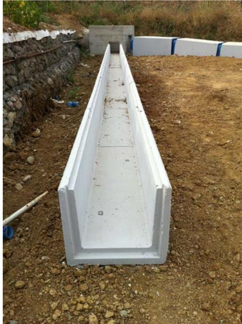
**Figura 5.22:** Canale prefabbricato per la misura della velocità e della portata afferente l'unità di trattamento.
