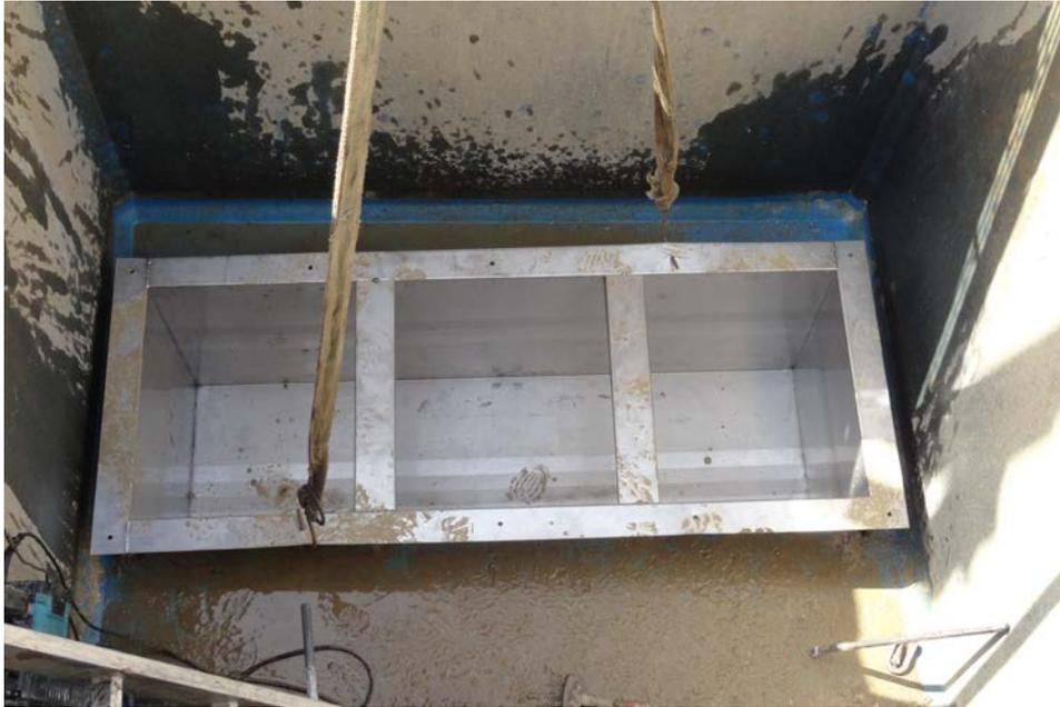
Figura 5.28: Cassone in acciaio Inox all'interno della tramoggia per il posizionamento delle apparecchiature per la pulizia della vasca.
