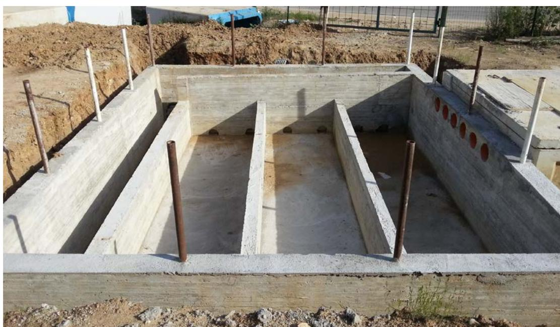
Figura 5.31: Sistema di setti all'interno dell'unità filtrante.
