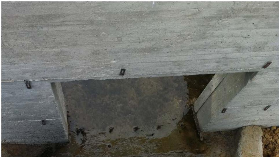
Figura 5.20: Apertura frontale per l'invio della portata meteorica eccedente verso lo scarico.
