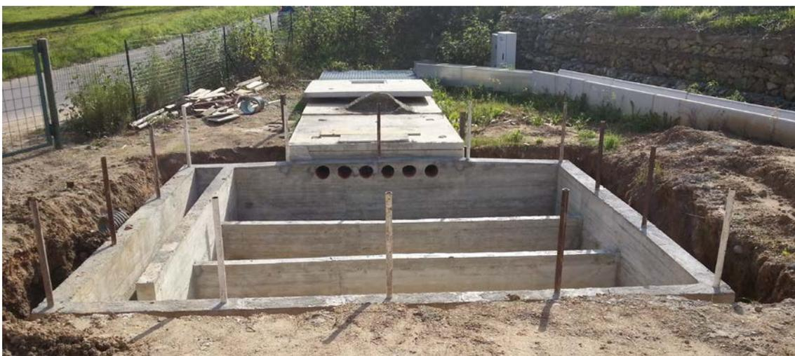
Figura 5.30: Unità di filtrazione dell'impianto di trattamento delle acque di dilavamento del Bacino Vermicelli.
