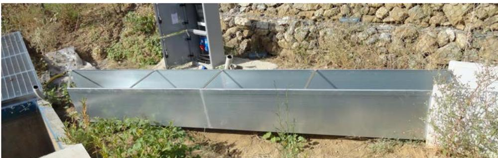
**Figura 5.24:** Collegamento tra canale di misura e vasca di sedimentazione mediante un canale in acciaio Inox.
