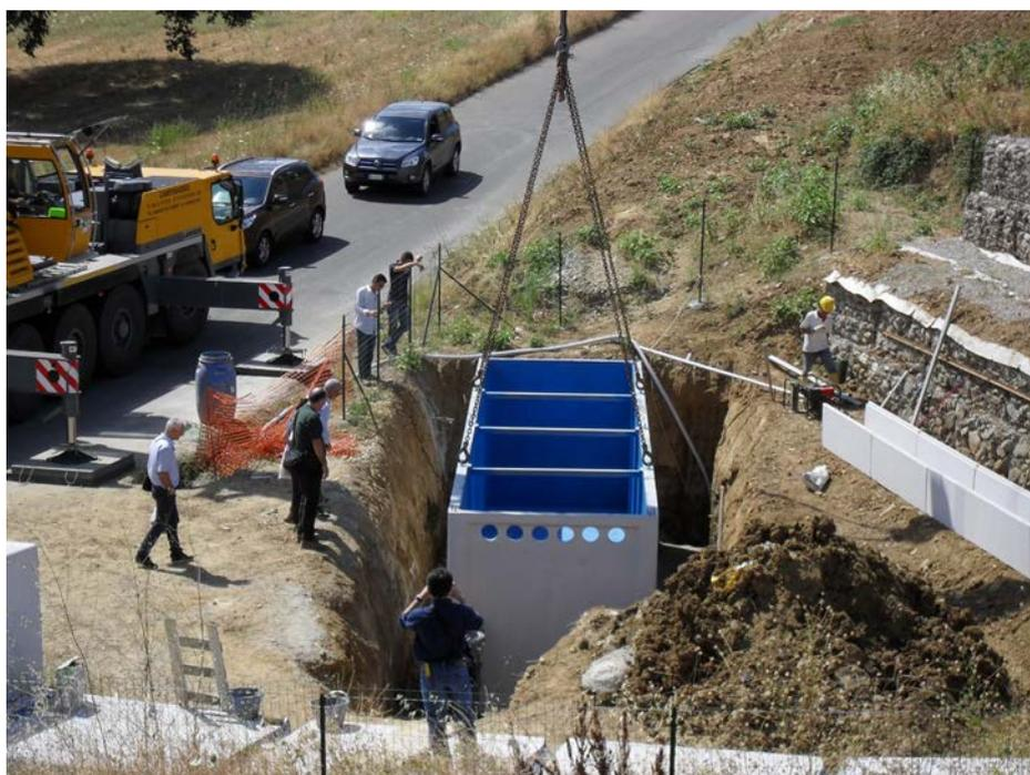
Figura 5.25: Vasca di sedimentazione dell'unità di trattamento presso il Bacino Vermicelli.
