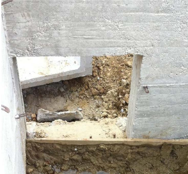
Figura 5.19: Apertura laterale necessaria a convogliare le acque di pioggia verso l'impianto di trattamento.
