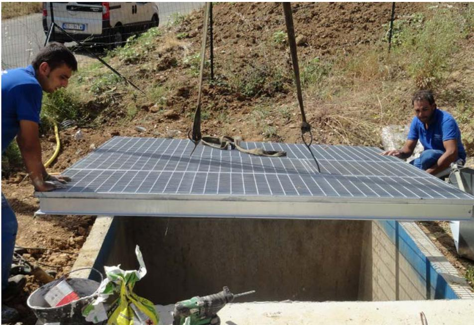
Figura 5.29: Copertura in grigliato per in corrispondenza degli apparecchi utilizzati per la pulizia della vasca.
