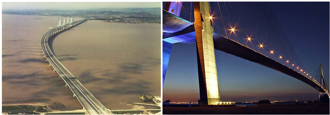
Figura 3.7 – Il “Second Severn Crossing” ed il “Pont de Normandie”
