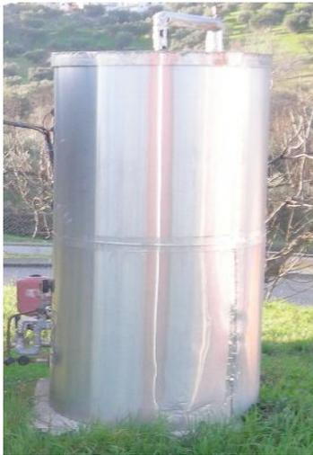
Fig. 5.20 - Serbatoio di accumulo (primario)
