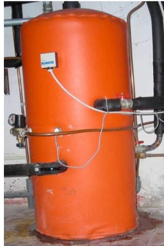
Fig. 5.21 - Serbatoio di accumulo (secondario)
