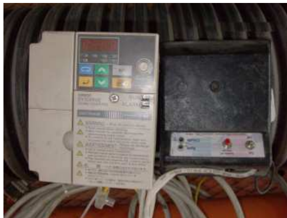
Figura 3.16. Inverter utilizzato per la regolazione della velocità di aperture e chiusura della saracinesca.
