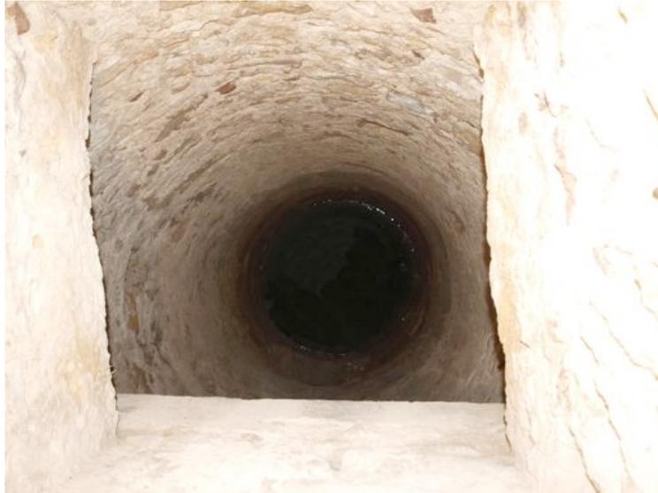
Crotona. Interno del pozzo per il prelievo delle acque dalla cisterna sottostante.
