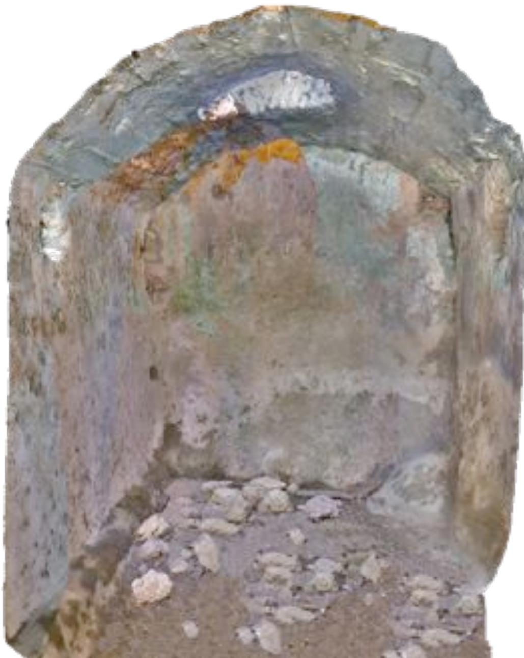
Stilo. Ricostruzione tridimensionale della cisterna situata al livello inferiore della torre circolare. In alto l'apertura praticata nella volta per il prelievo dell'acqua.
