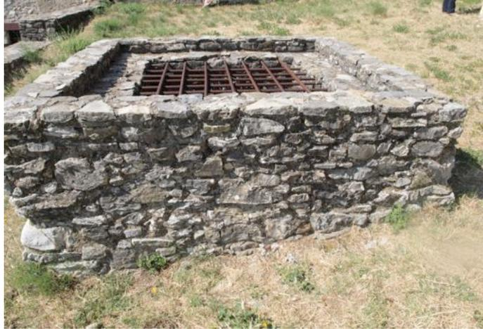
Malvito. Bocca della cisterna localizzata nel cortile ed utilizzata per il prelievo delle acque dall’ambiente sottostante
