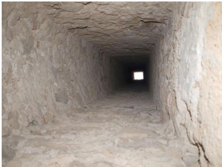
Crotona. Condotta verticale che convoglia le acque dall'apertura localizzata al terzo livello (visibile in alto) al bacino localizzato al pianterreno della torre.
