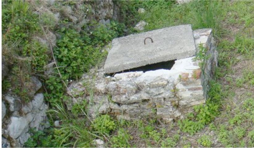
Bivona. Pozzo di forma quadrata per il prelievo dell'acqua dalla cisterna sottostante
