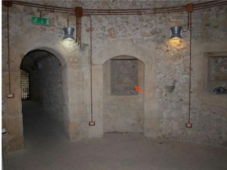
Crotone. Secondo livello della Torre Aiutante con indicazione dell'apertura per il prelievo dell'acqua dalla cisterna sottostante.
