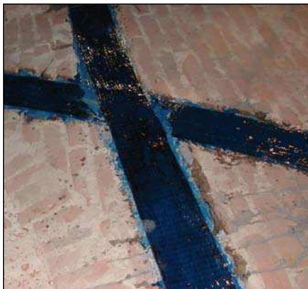
Figura 1.11: Applicazione di nastro in CFRP sull'estradosso di una volta in muratura
