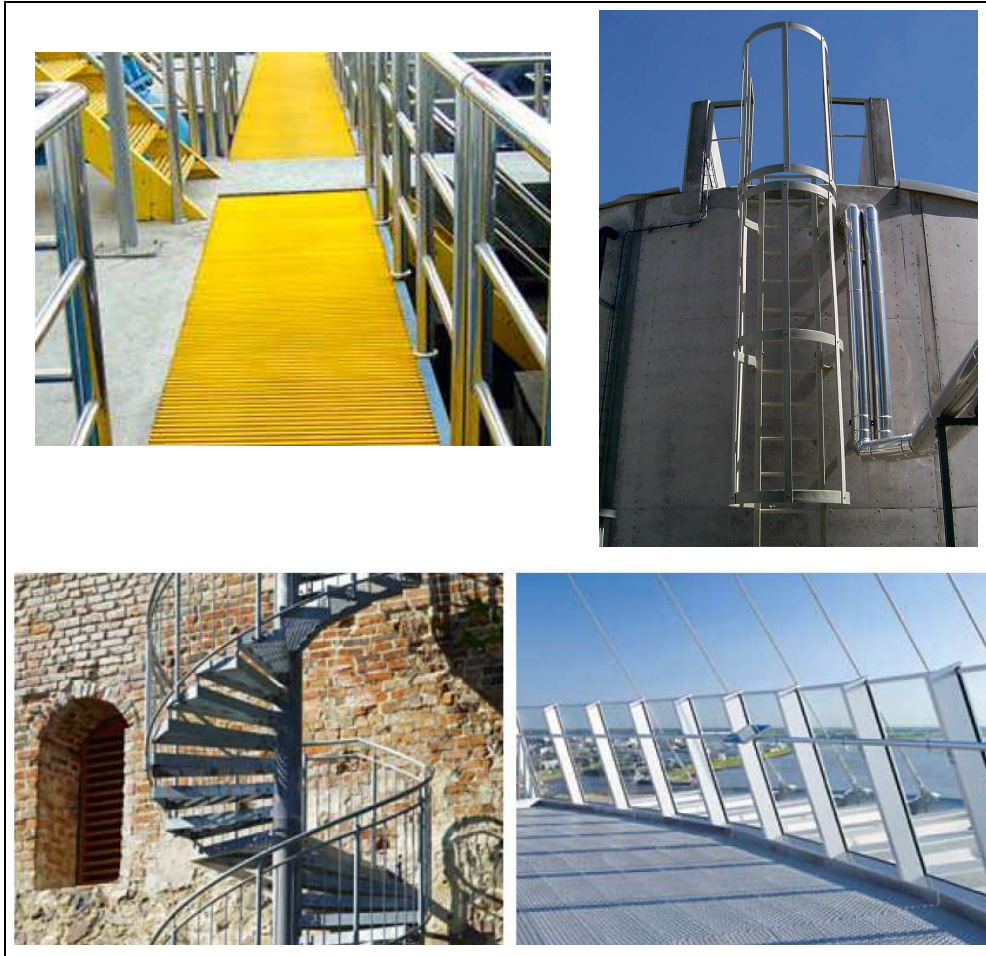
Figura 1.15 : Esempi di realizzazioni con profilati in FRP
