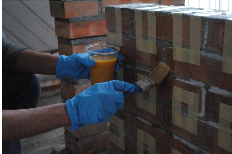
Figura 2.5 Applicazione del primer
