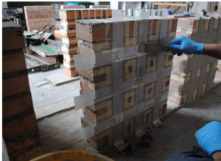
Figura 2.7 Rinforzo FRCM in fibra di vetro
