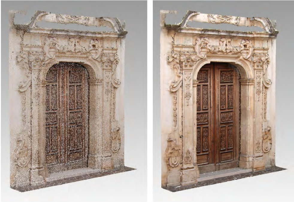
Fig. 5.17 – Portale della chiesa di S. Maria delle Vergini (Cosenza). Nuvola di punti, ottenuta da fotogrammi processati con Agisoft PhotoScan (1 milioni di punti); il modello poligonale, è stato realizzato in Geomagic Studio 12 ed è composto da 2 milioni di triangoli.
