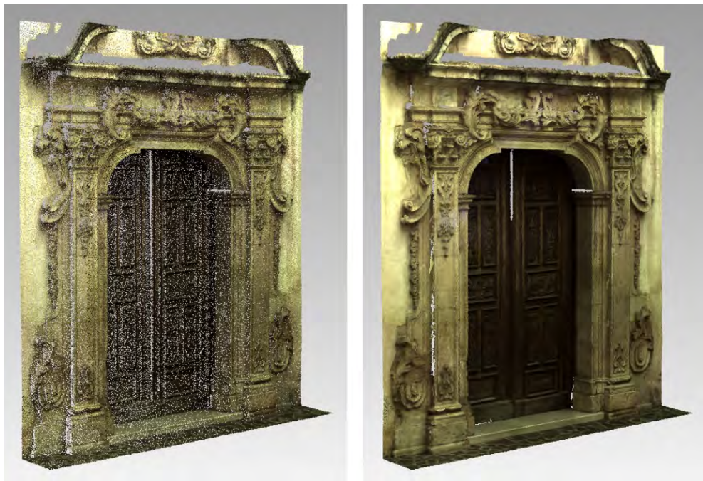
Fig. 5.14 – Portale della chiesa di S. Maria delle Vergini (Cosenza). Nuvola di punti da Laser scanner (1.6 milioni. di punti.) e modello poligonale costituito da 2 milioni. di triangoli.
