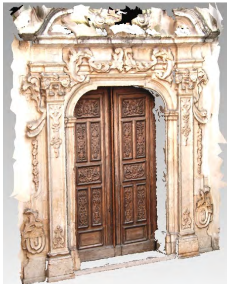
Fig. 5.16 – Portale della chiesa di S. Maria delle Vergini (Cosenza). Modello poligonale del solo portale, ottenuto con il servizio web Autodesk/123D Catch, composto da 63240 triangoli.
