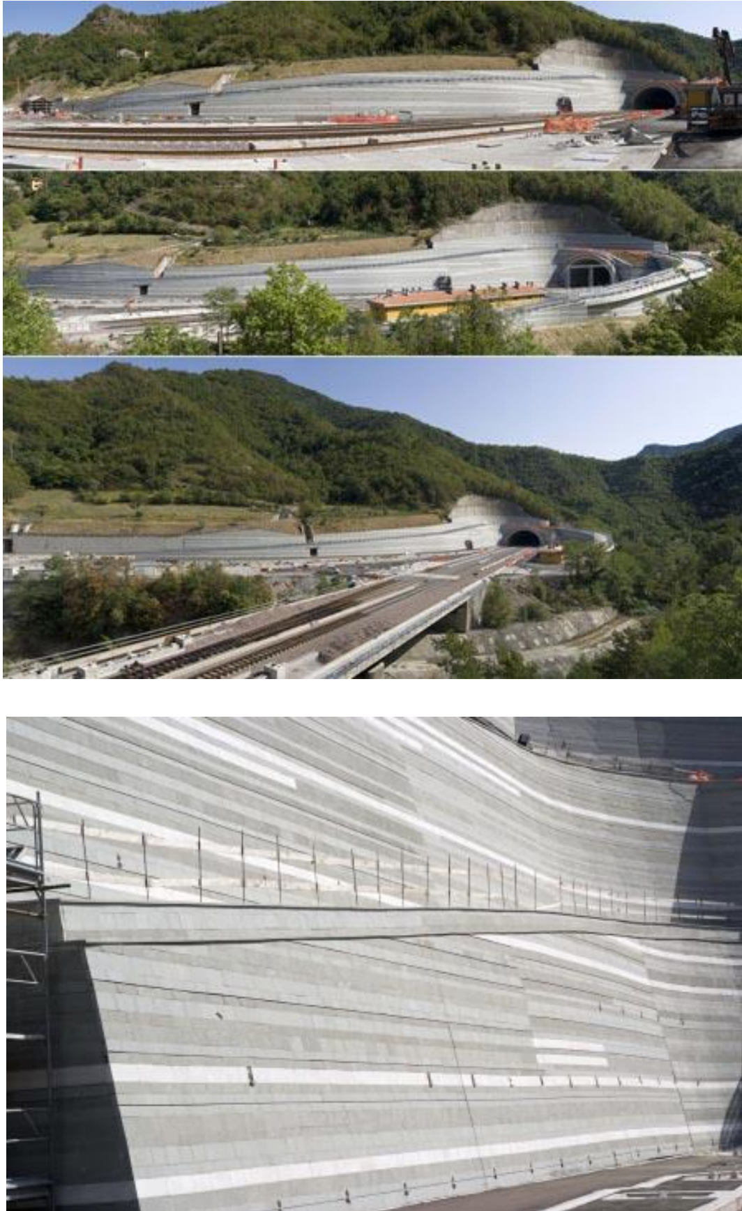
fig. 52 Nuovo fornice per l'Alta Velocità, Firenzuola (Fi): Visivamente la presenza cementizia è mitigata dall'uso della pietra: arenarie locali che assecondano le curve in parte di scavo ed in parte naturali del sito
