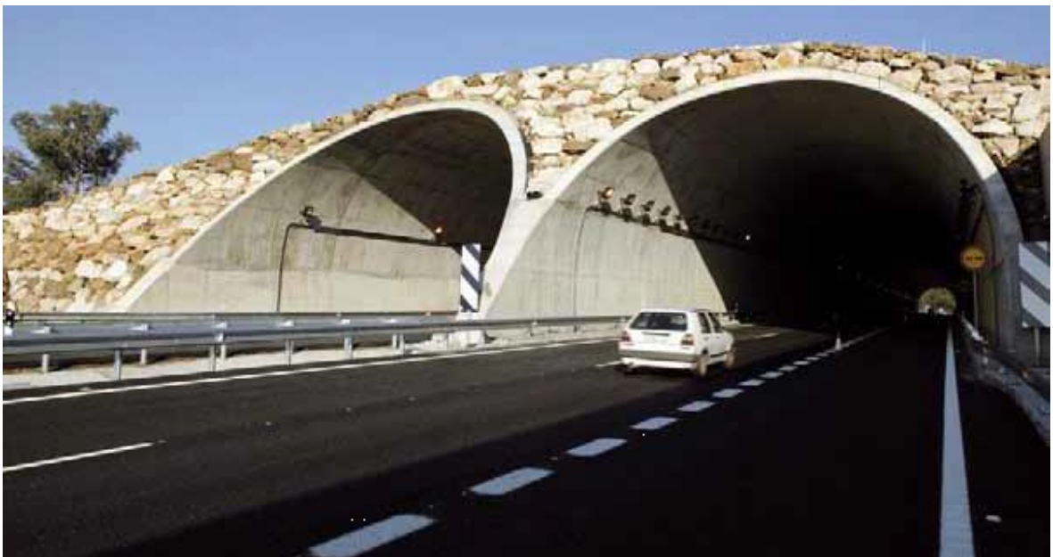
fig. 51 Superstrada Jerez-Los Barrios (Andalusia) Alcune tecniche costruttive, come la costruzione a forma di becco d'anatra delle entrate alle gallerie, consentono la riduzione dell'impatto visivo
