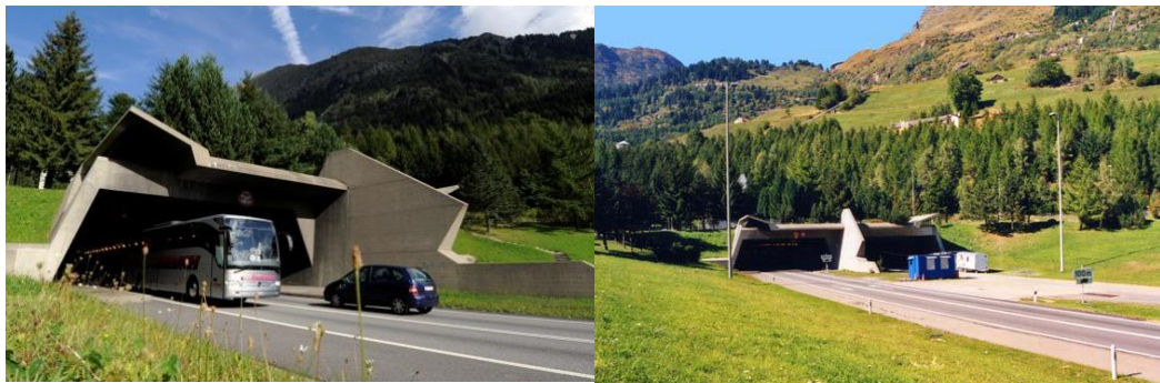
fig. 37 Portale di ingresso della galleria autostradale del San Gottardo
