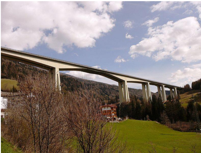
fig. 36 viadotto che passa sopra il paese di Colle Isarco
