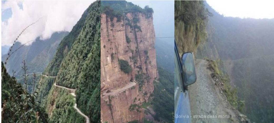
fig. 24 Bolivia strada della morte: Il tracciato non entra in conflitto con le componenti morfologiche, ma non è adeguato ai requisiti di sicurezza comodità ed efficienza.
