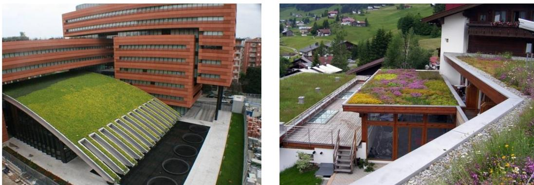
Fig. 1.8. Esempi di coperture a verde estensive.
