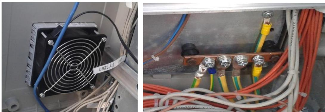
Fig. 2.62. Particolari chassis-9188 e nodo di terra
