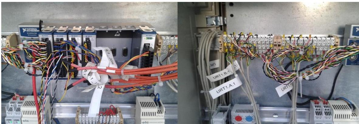
Fig. 2.61. Particolari chassis-9188 e morsetti
