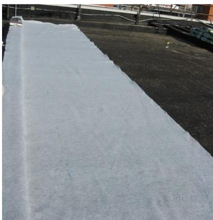
*Fig. 2.53. Feltro di protezione ed accumulo*
