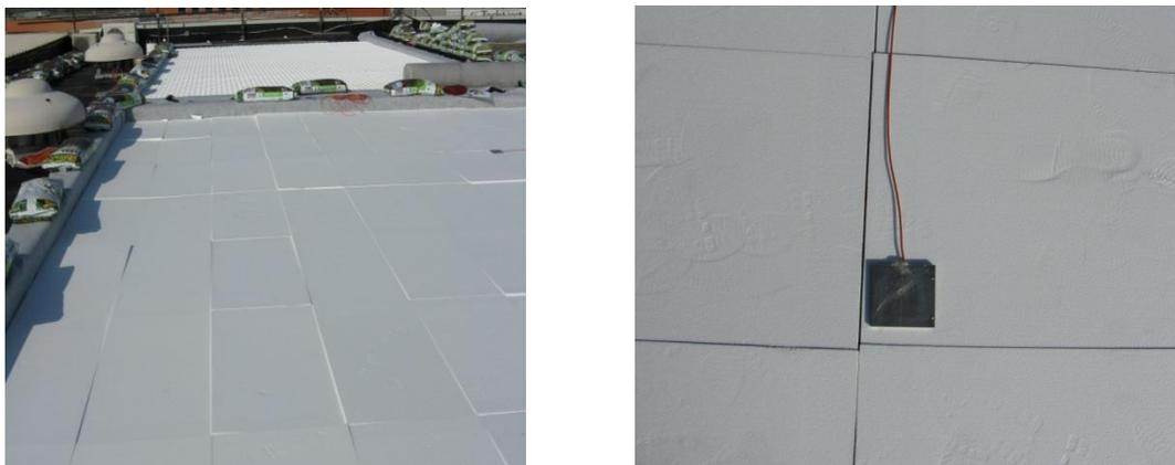
*Fig. 2.56. Strato di isolamento termico*
