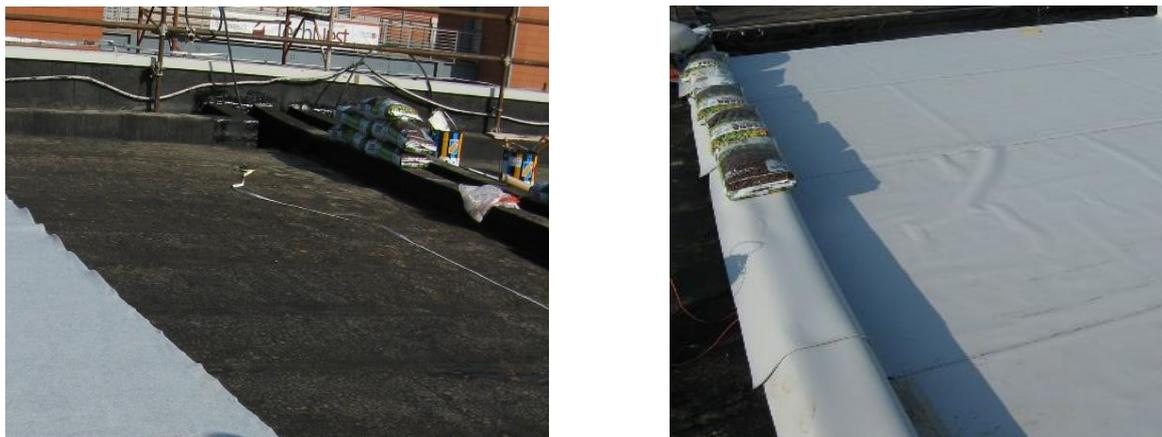
*Fig. 2.52. Membrane antiradice bituminosa ed in pvc*
