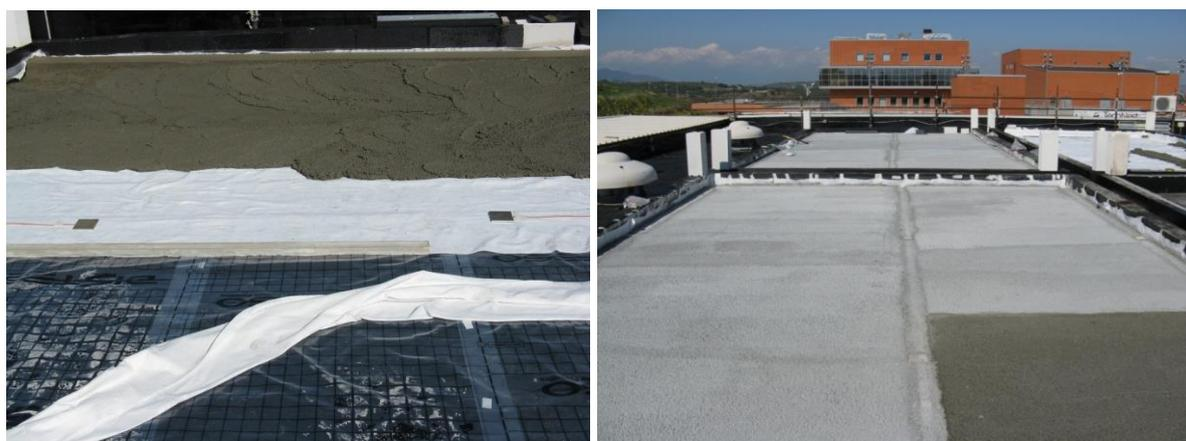
*Fig. 2.51. Massetto alleggerito delle pendenze*
